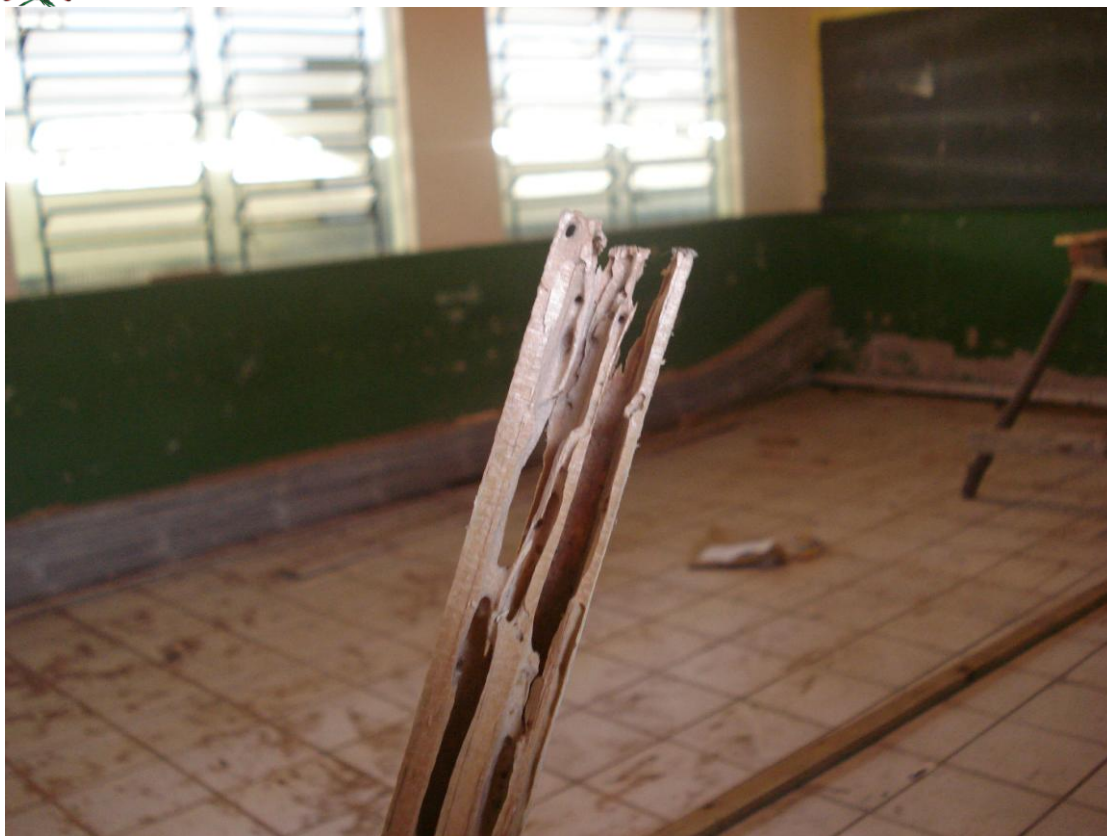
Madeira do telhado com infestação de cupim
