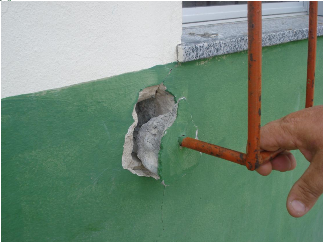
Falta chumbamento nas grades de proteção
