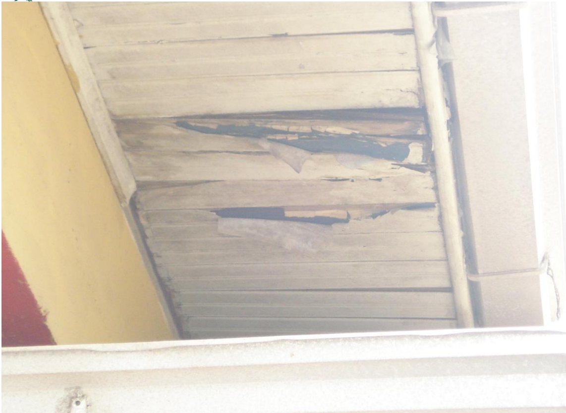
Forros infestados de cupim, sujeitos a desabamento.
