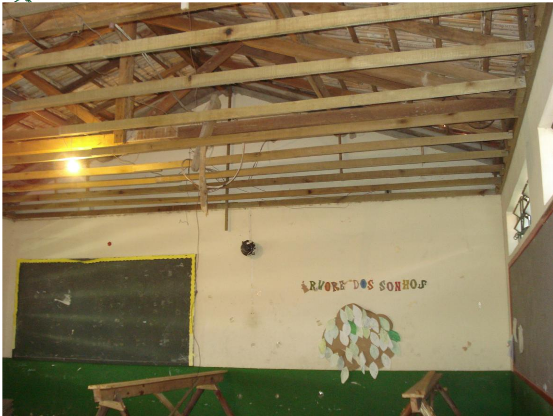
Telhado que desabou encontra-se em manutenção
