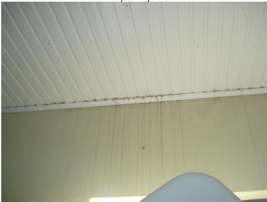
Infiltrações nas paredes
