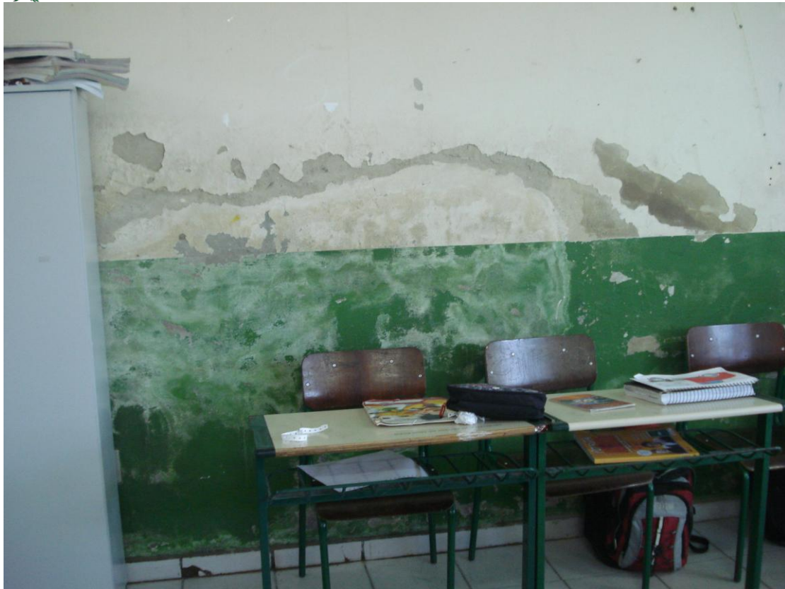
Infiltrações nas paredes
