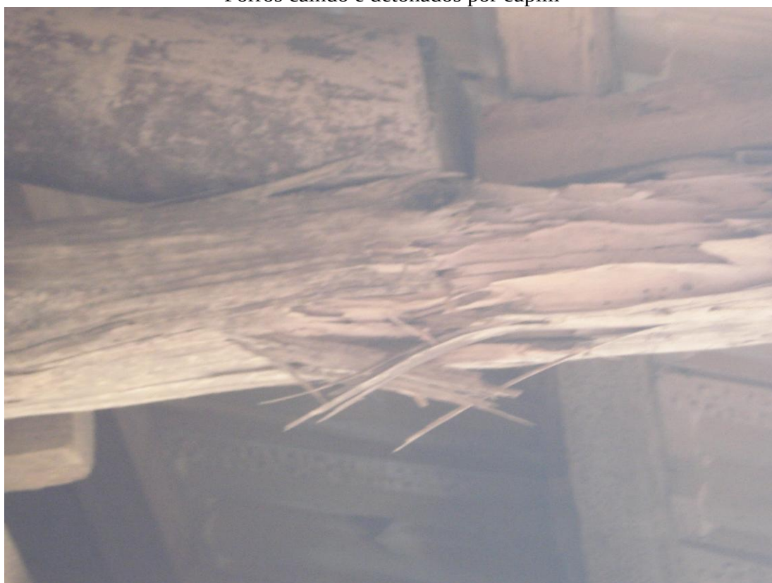
Forros caindo e detonados por cupim
