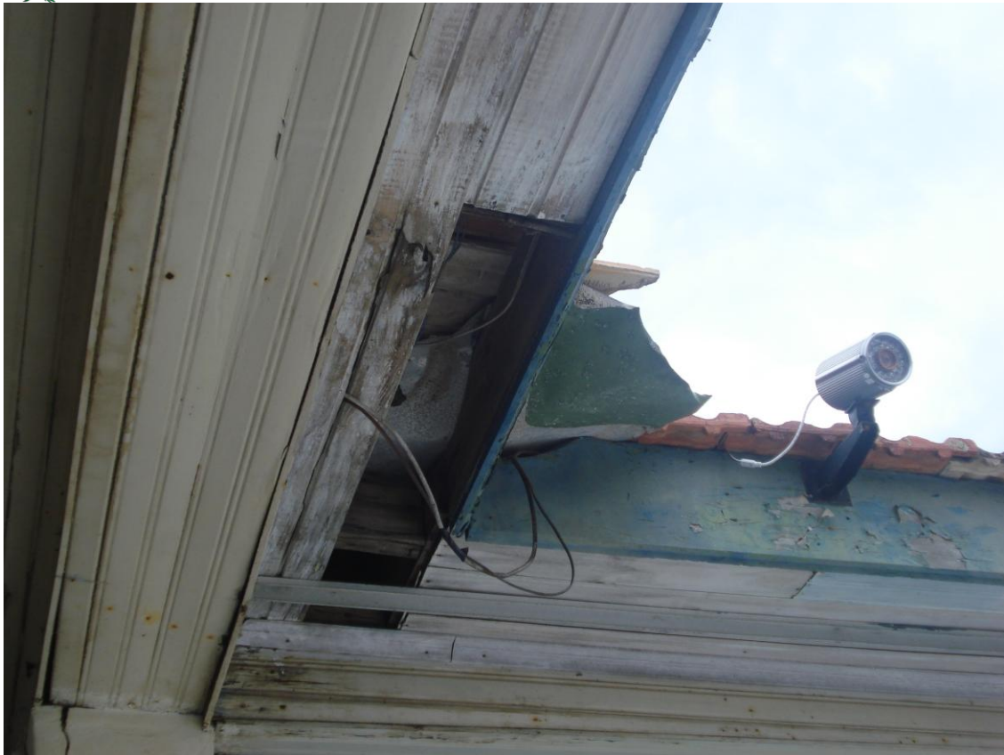
Forro caindo devido à infestação de cupins e infiltrações.
