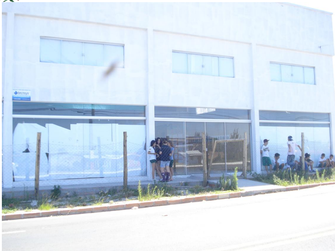
Falta de muros em volta do prédio escolar provisório.
