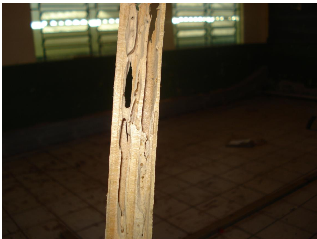
Madeira do telhado com infestação de cupim
