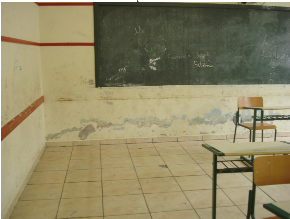
Pisos das paredes caindo.
