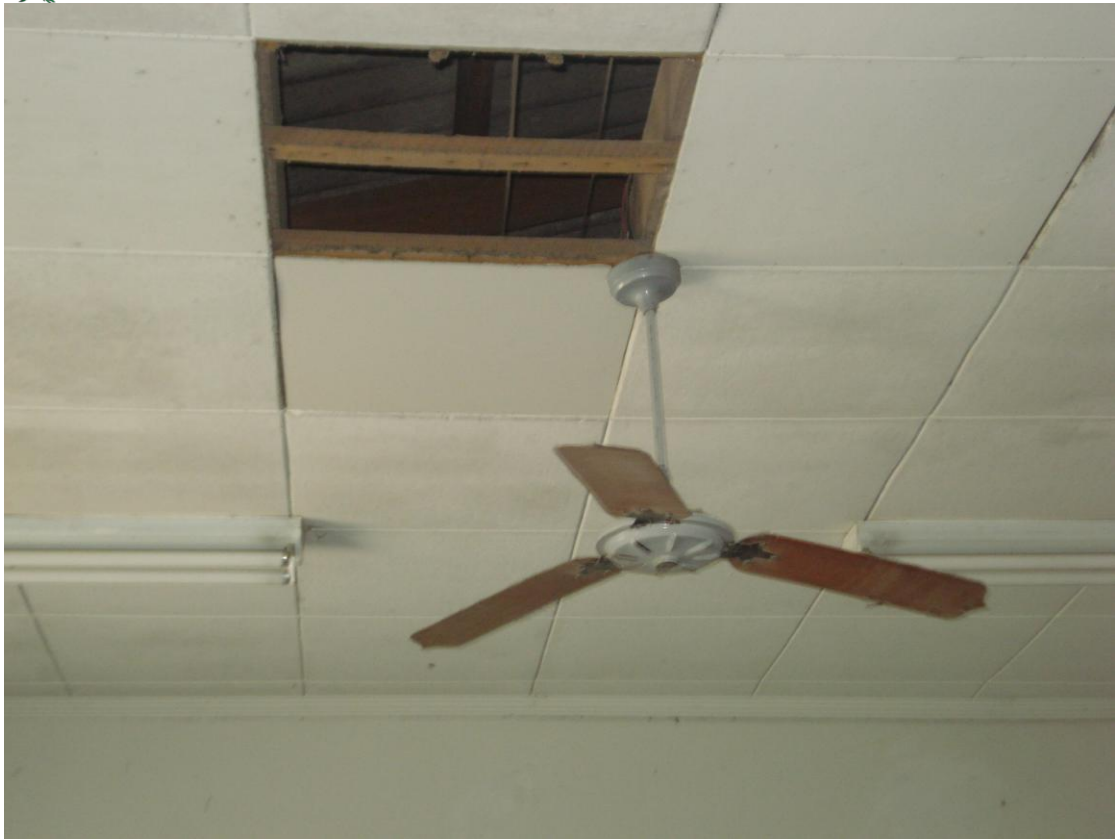
Ventiladores de teto não podem ser ligados porque correm o risco de cair
