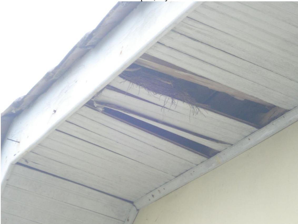
Forros infestados de cupim, sujeitos a desabamento.
