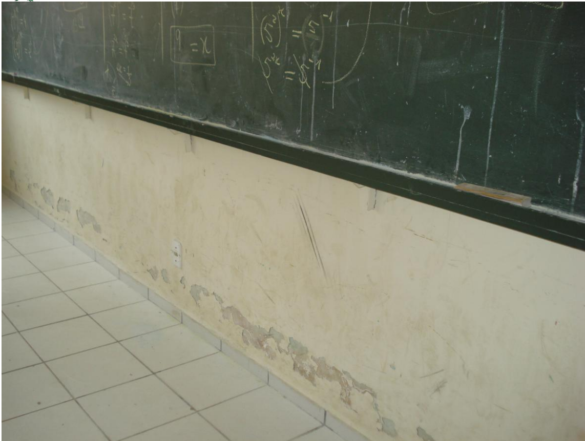
Paredes com infiltrações e pisos caindo.
