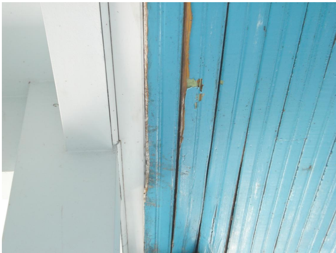
Forro caindo e infestado de cupim, correndo o risco de desabamento
