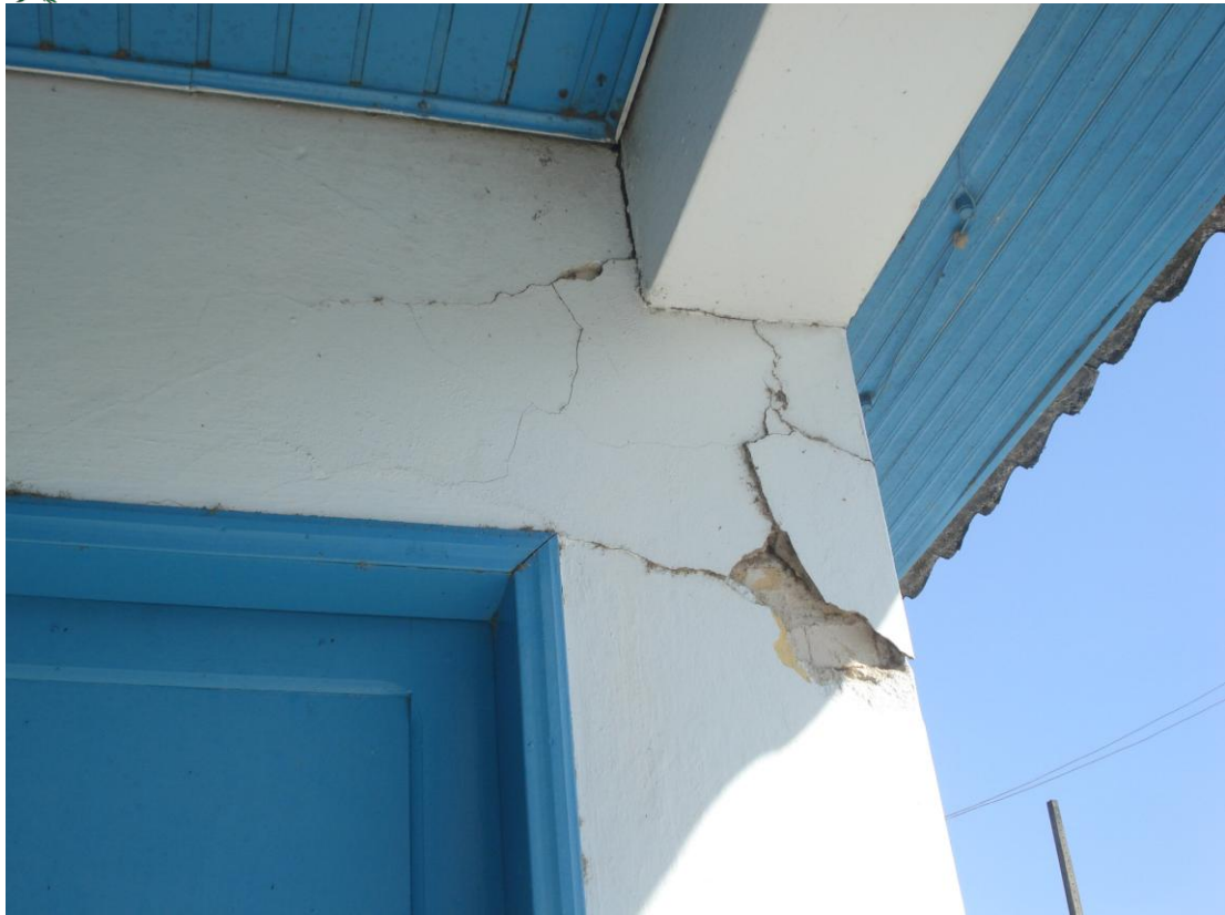
Rachaduras e forros infestados de cupim.
