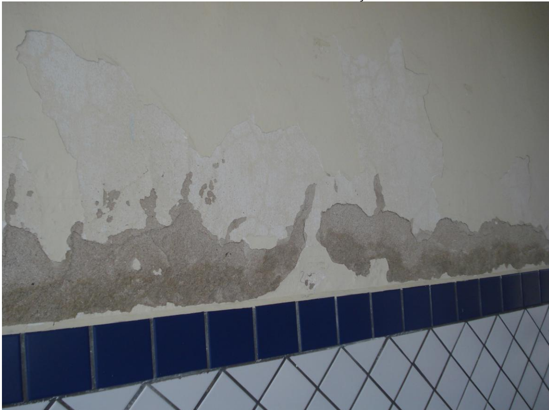
Paredes rachadas e com infiltrações.
