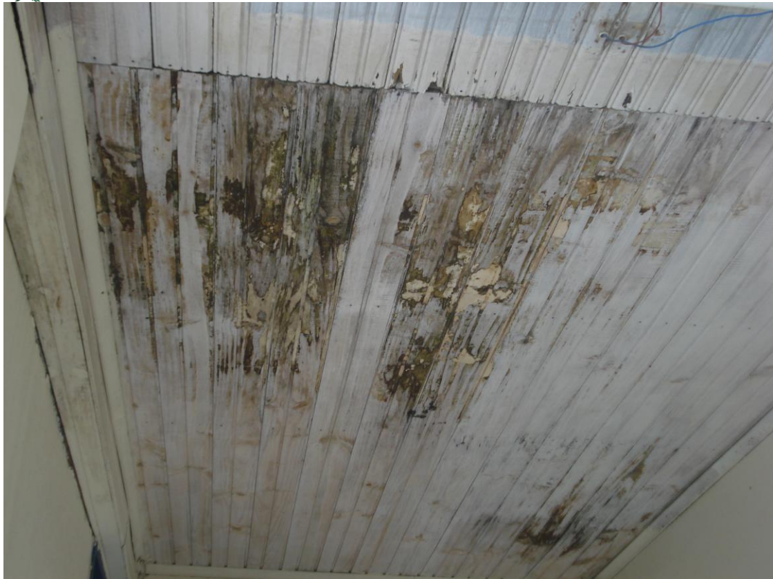
Infiltrações em toda estrutura, sujeita a desabamentos
