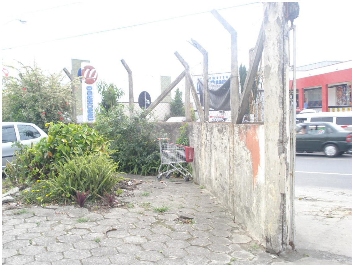
Muro de entrada comprometido com ferros da viga de sustentação aparecendo.
