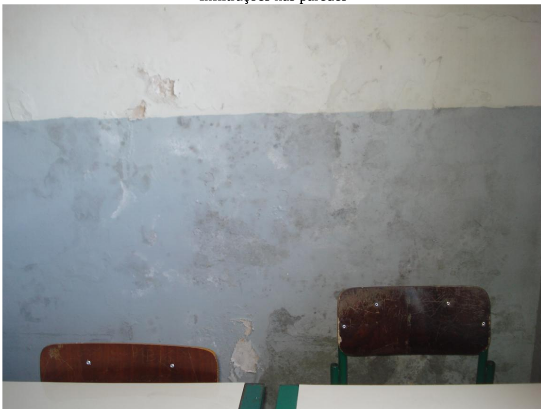
Infiltrações nas paredes
