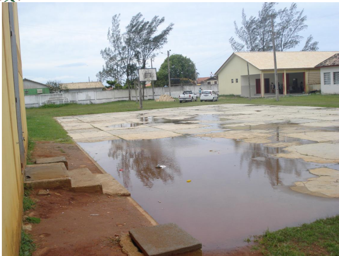
Tacos da quadra do ginásio quebrados e se soltando.
