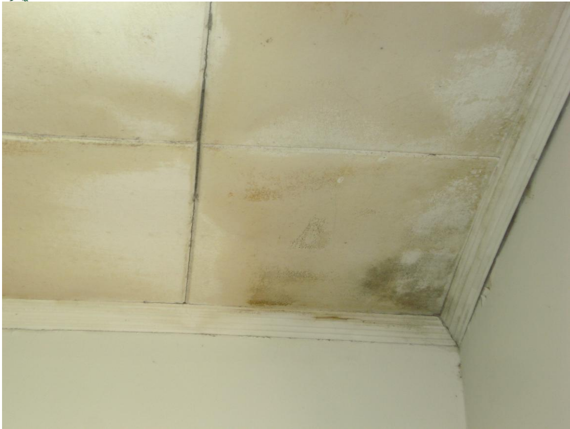
Infiltrações no telhado
