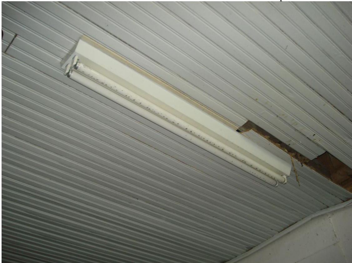
Forro do laboratório de ciências caindo infestado de cupim
