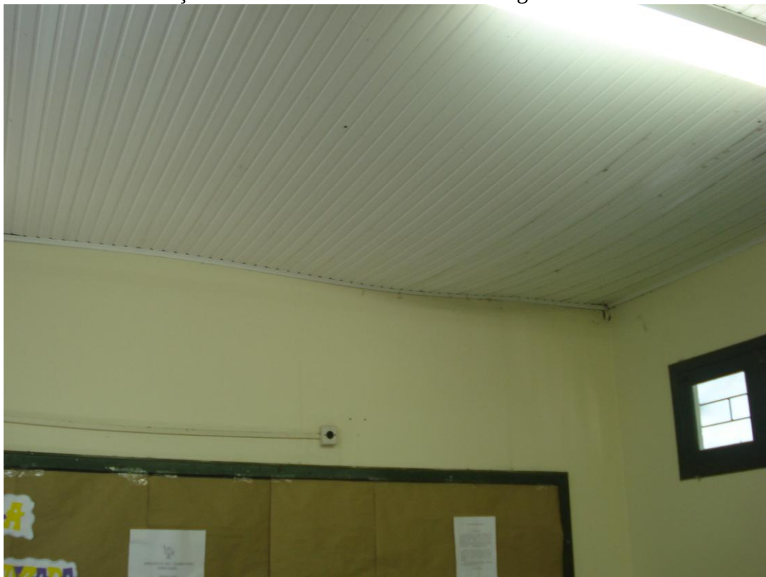
Sala informatizada sem climatizadores causam o superaquecimento dos computadores e infiltrações causam abaulamento no forro e goteiras na sala
