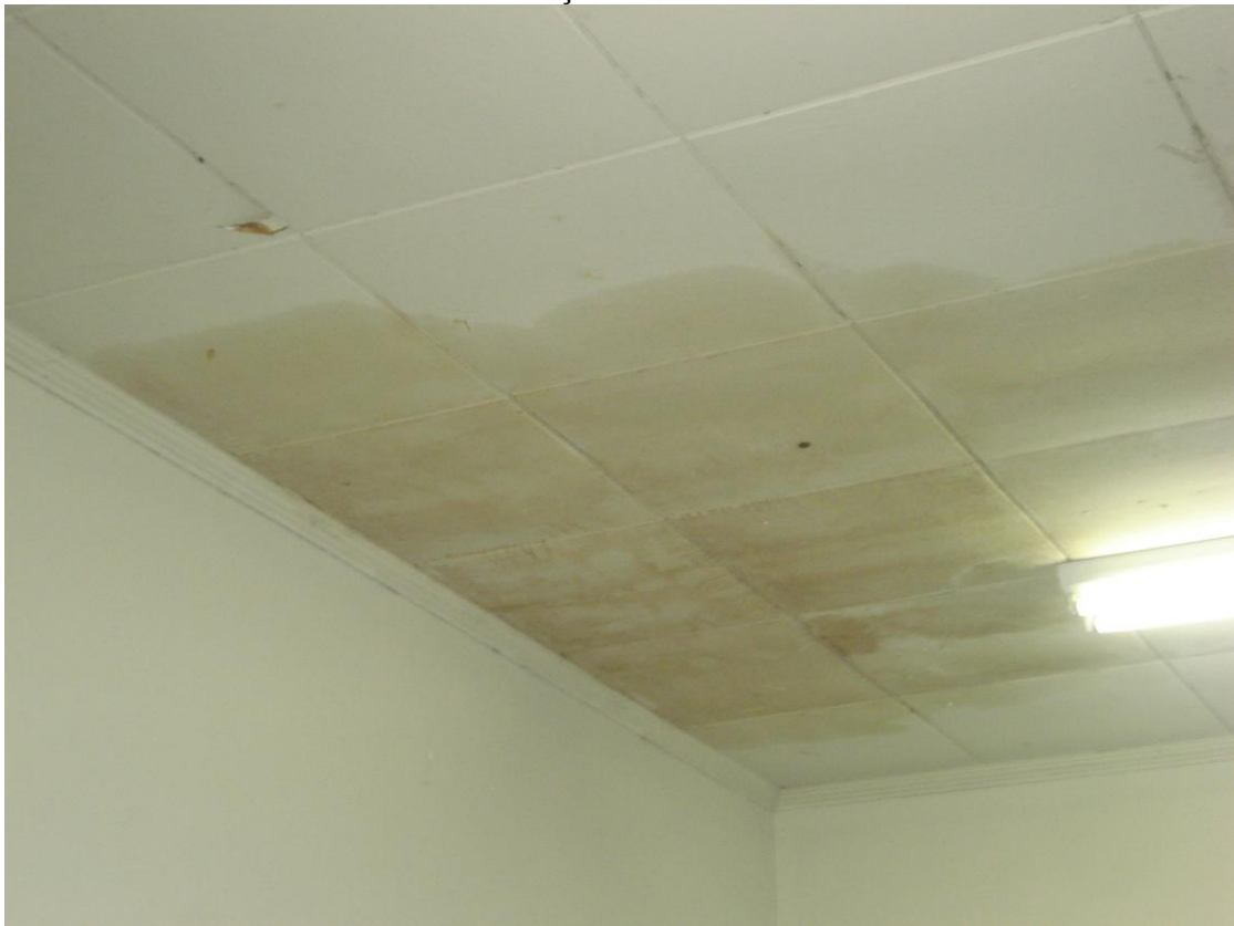
Infiltrações no telhado
