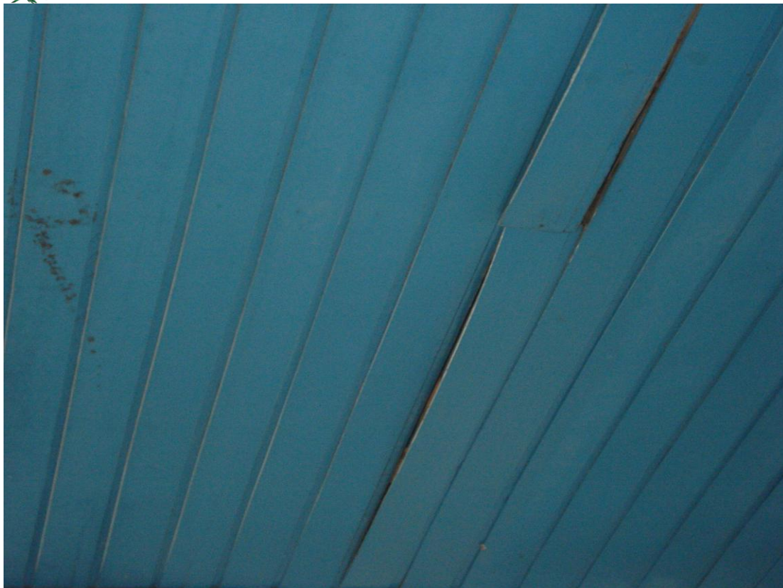
Forro caindo e infestado de cupim, correndo o risco de desabamento
