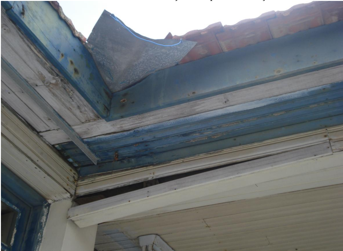
Forro caindo devido à infestação de cupins e infiltrações.
