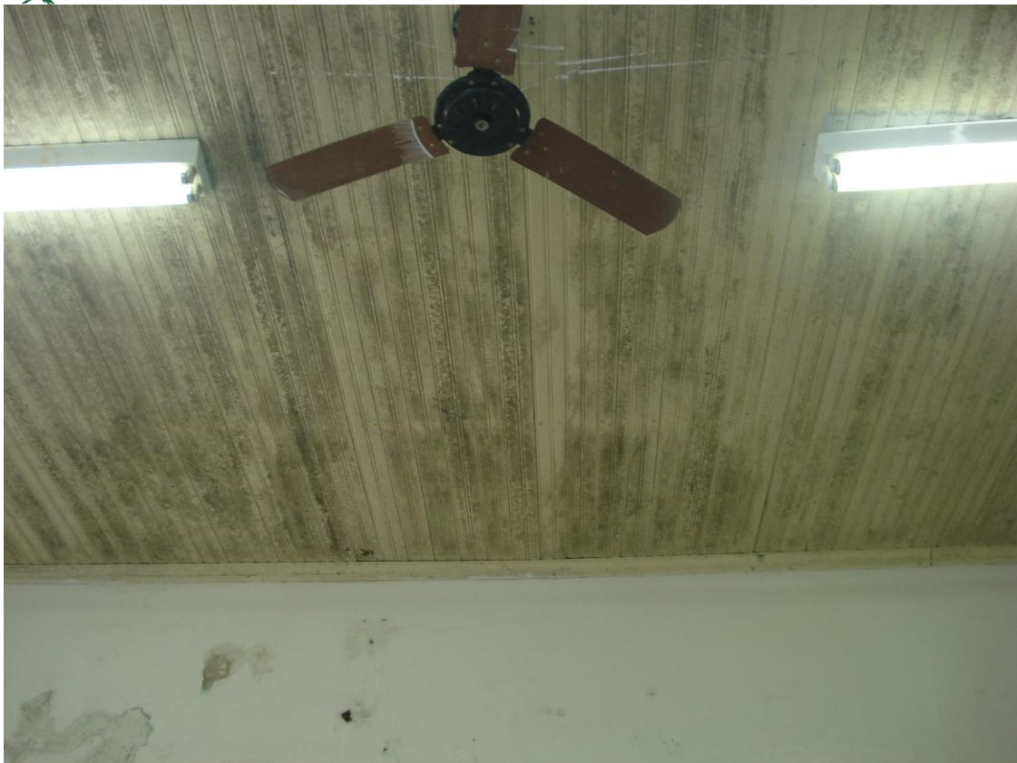
Infiltrações nos tetos e paredes.
