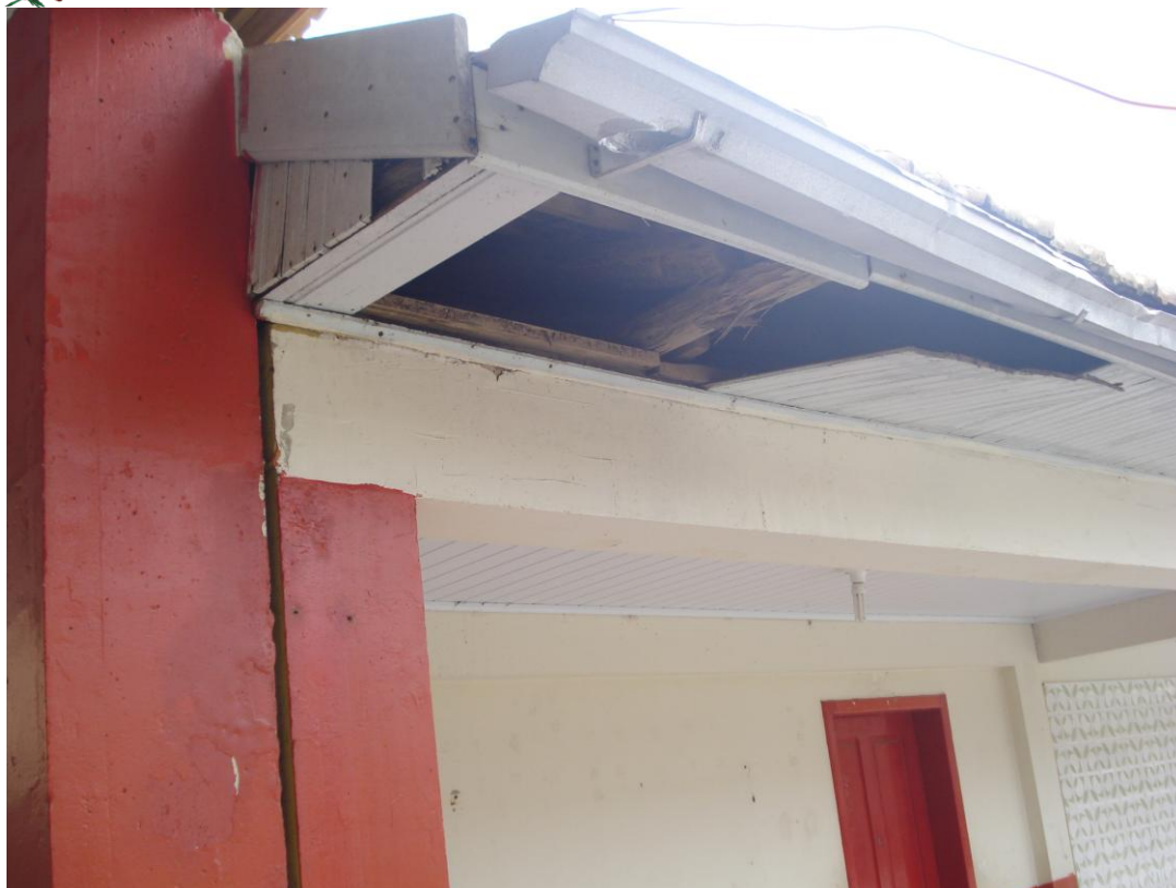
Forros caindo e detonados por cupim
