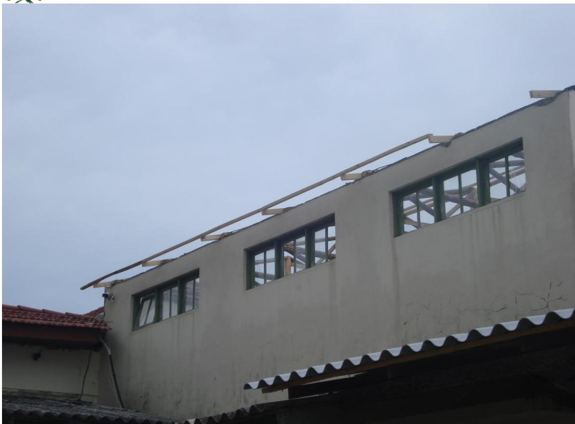
Telhado de uma sala de aula que desabou e está sendo reconstruído.
