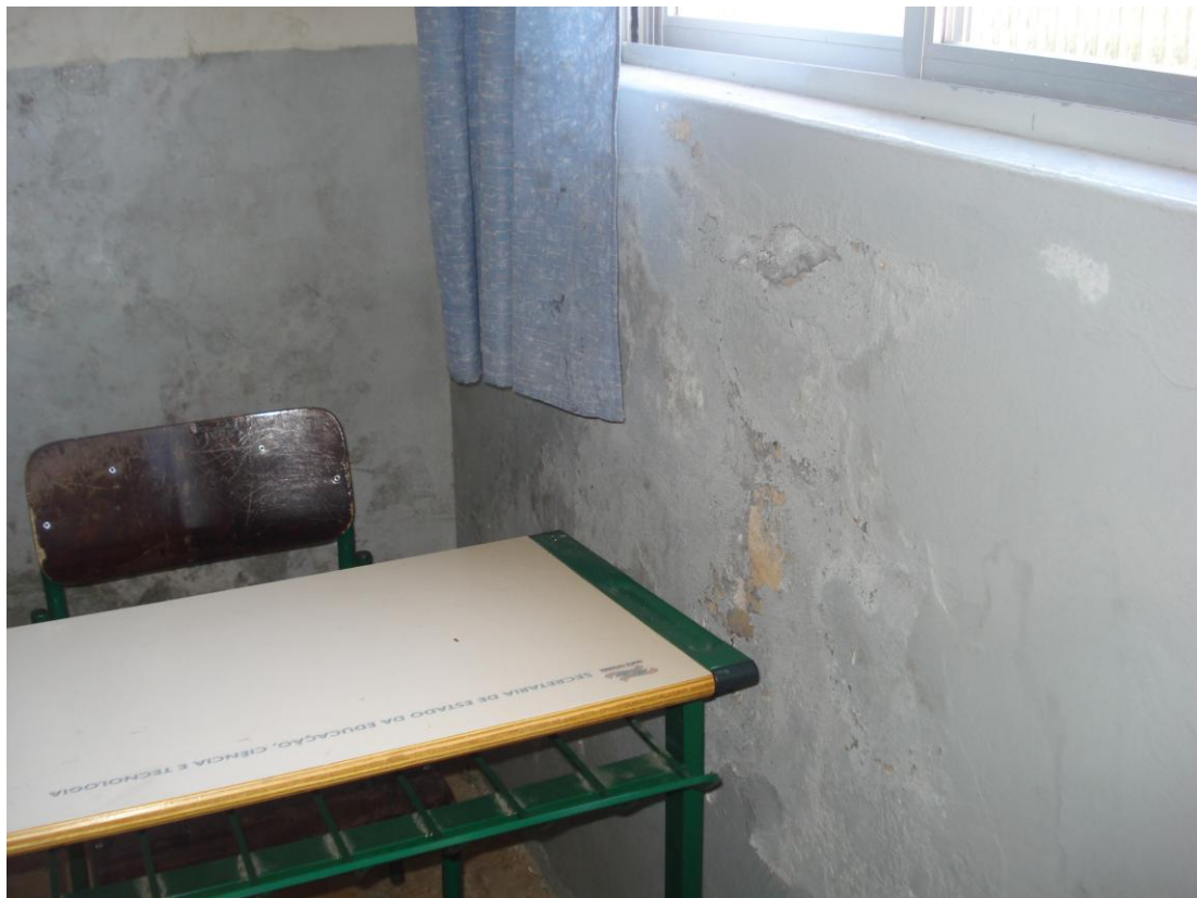
Infiltrações nas paredes
