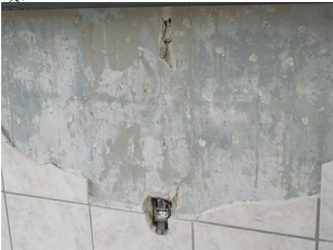
Pisos das paredes caindo.
