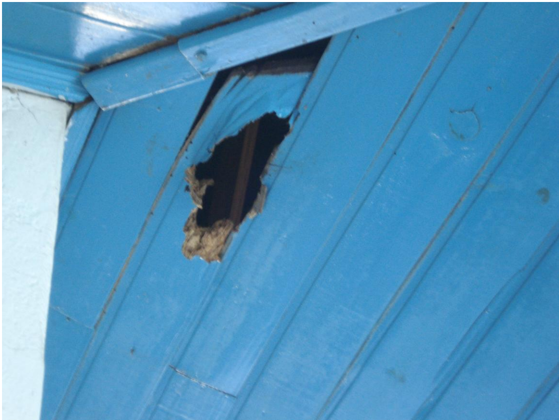
Rachaduras e forros infestados de cupim.
