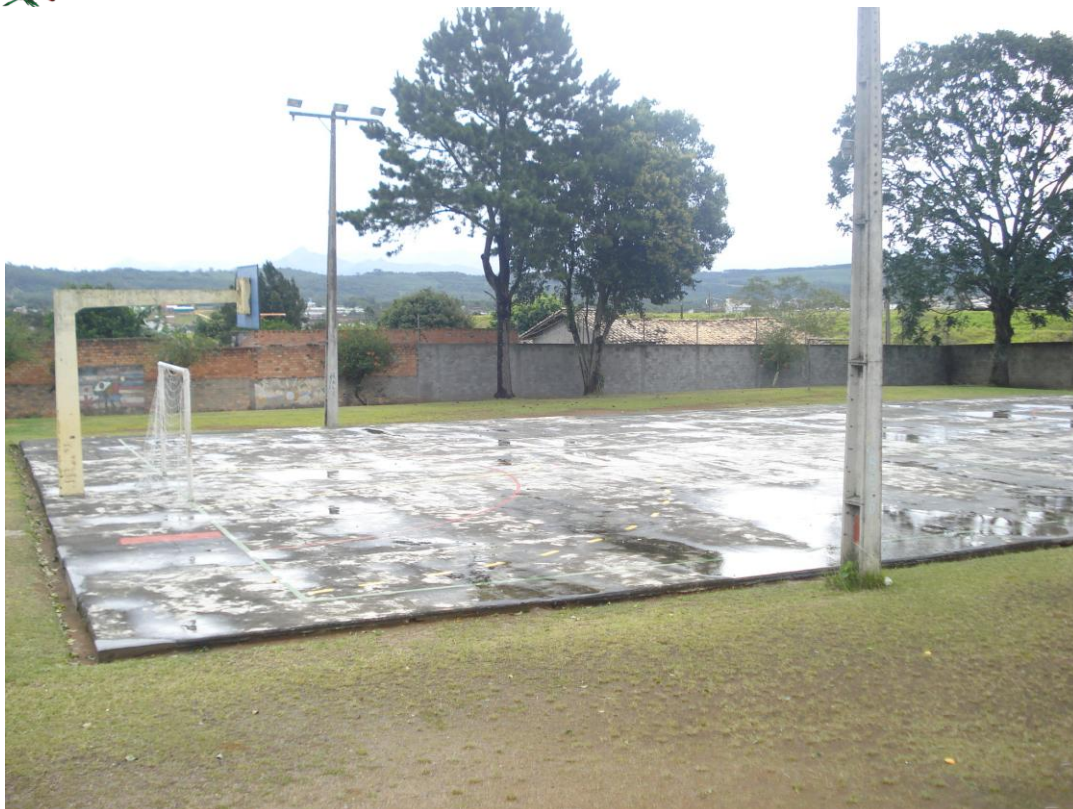
Quadra descoberta necessitando de reforma.
