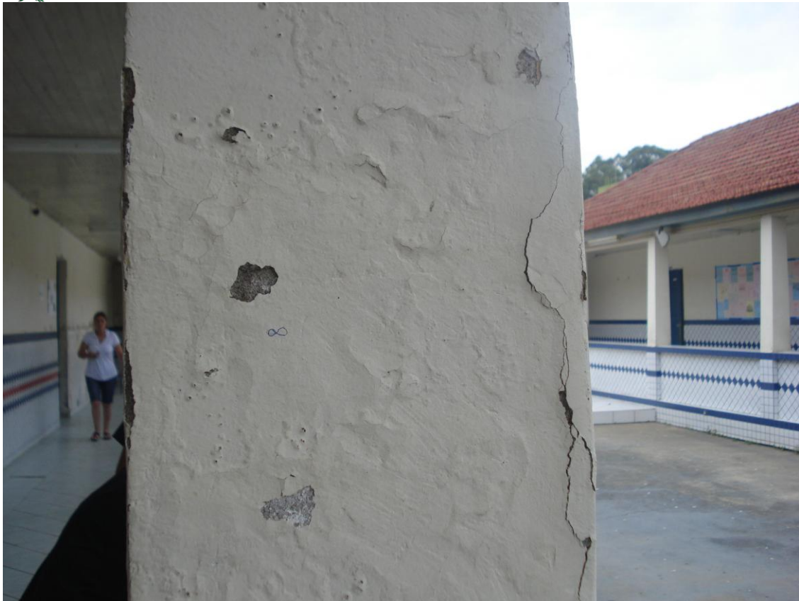
Paredes rachadas e com infiltrações.
