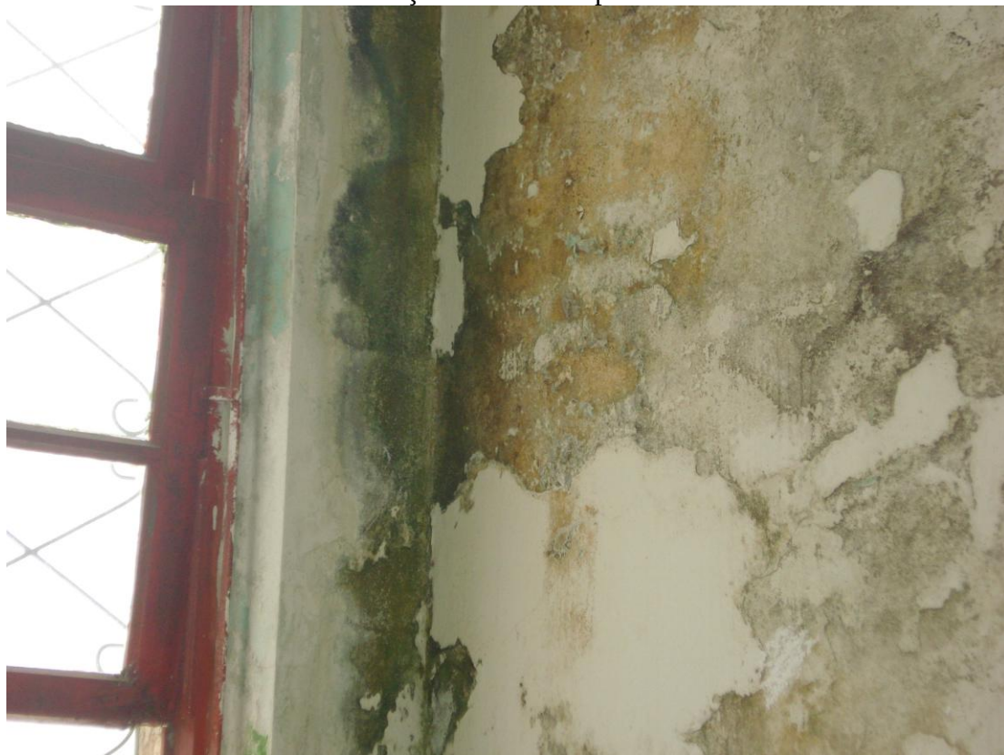
Infiltrações nos tetos e paredes.
