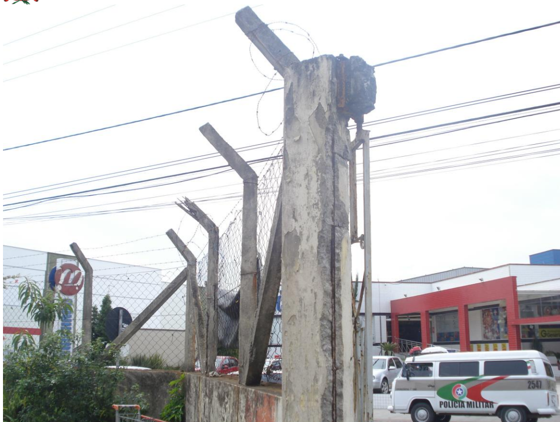
Muro de entrada comprometido com ferros da viga de sustentação aparecendo.
