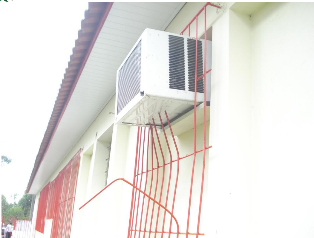
Invasão de vândalos causam depredações na escola.
