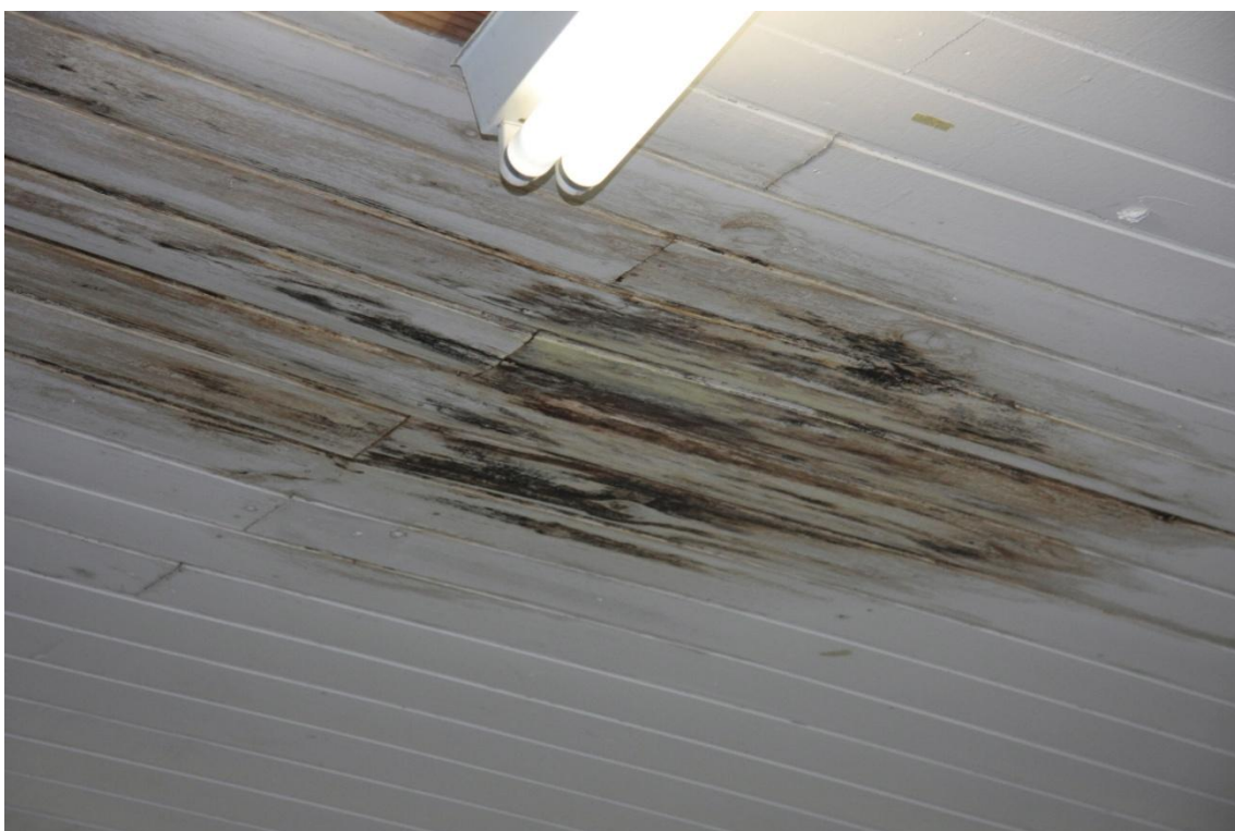
Forros caindo e com infiltrações
