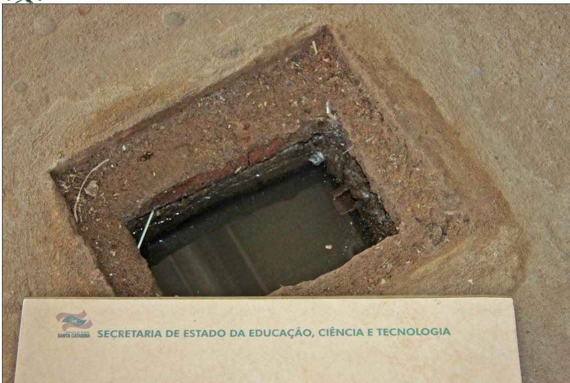
Vala aberta no pátio
