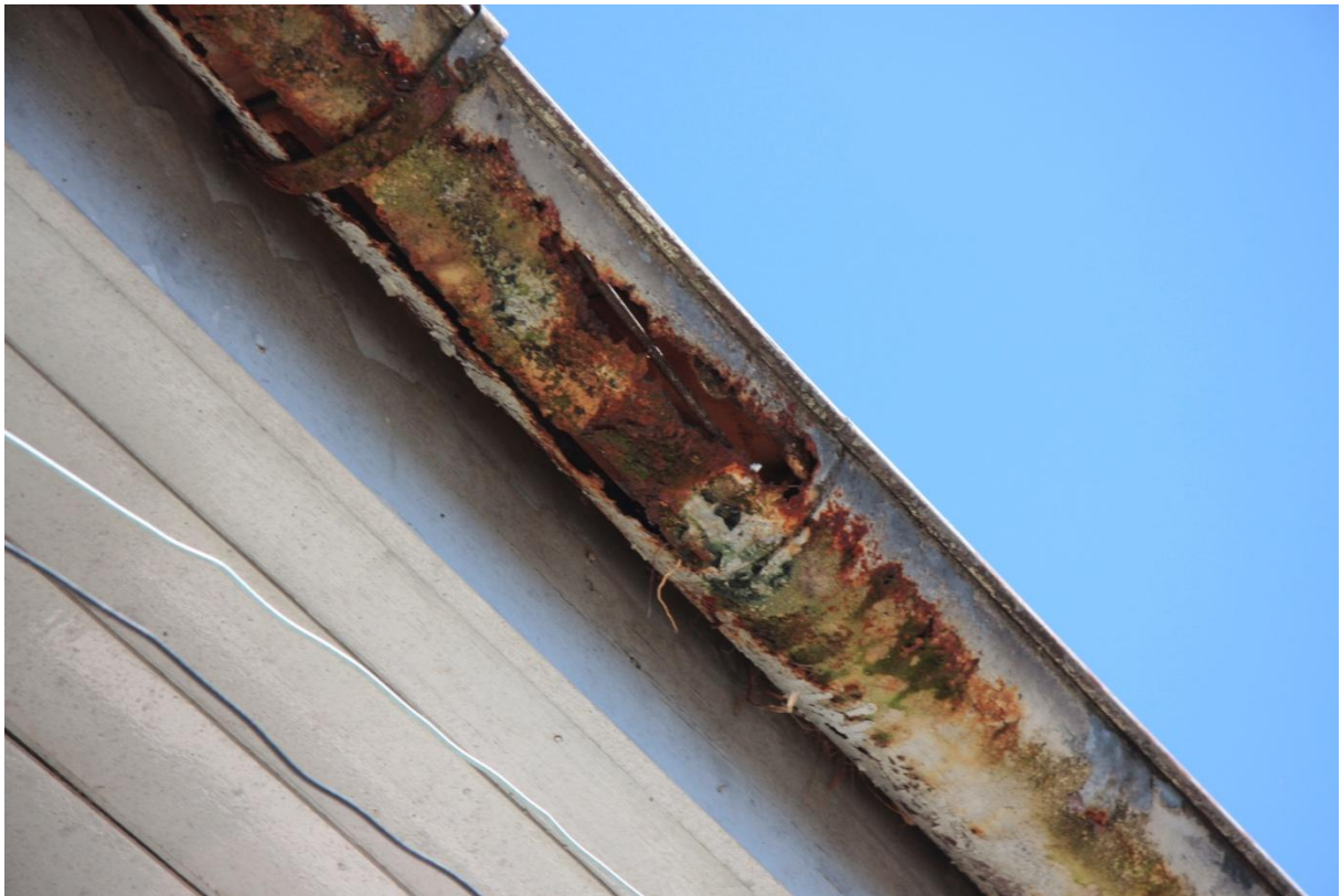
Calhas de chuva em péssimas condições
