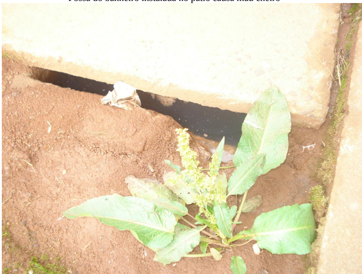
Fossa do banheiro instalada no pátio causa mau cheiro
