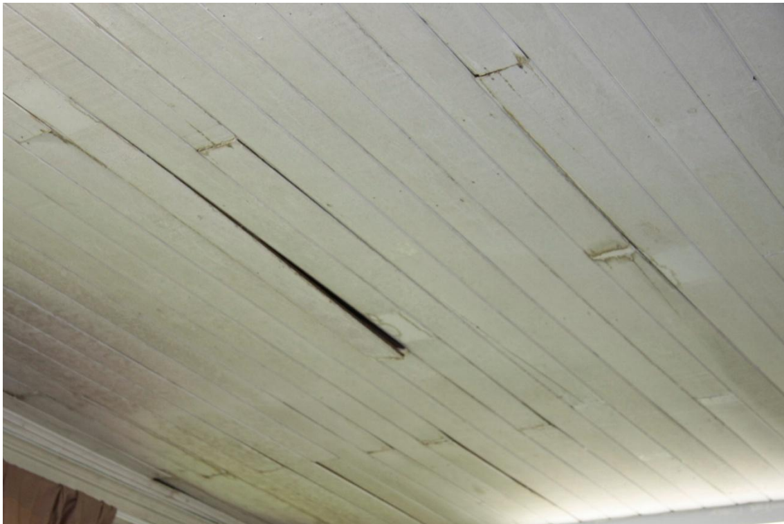
Forro caindo e com infiltrações em toda a ala de madeira. Uma das salas está interditada.
