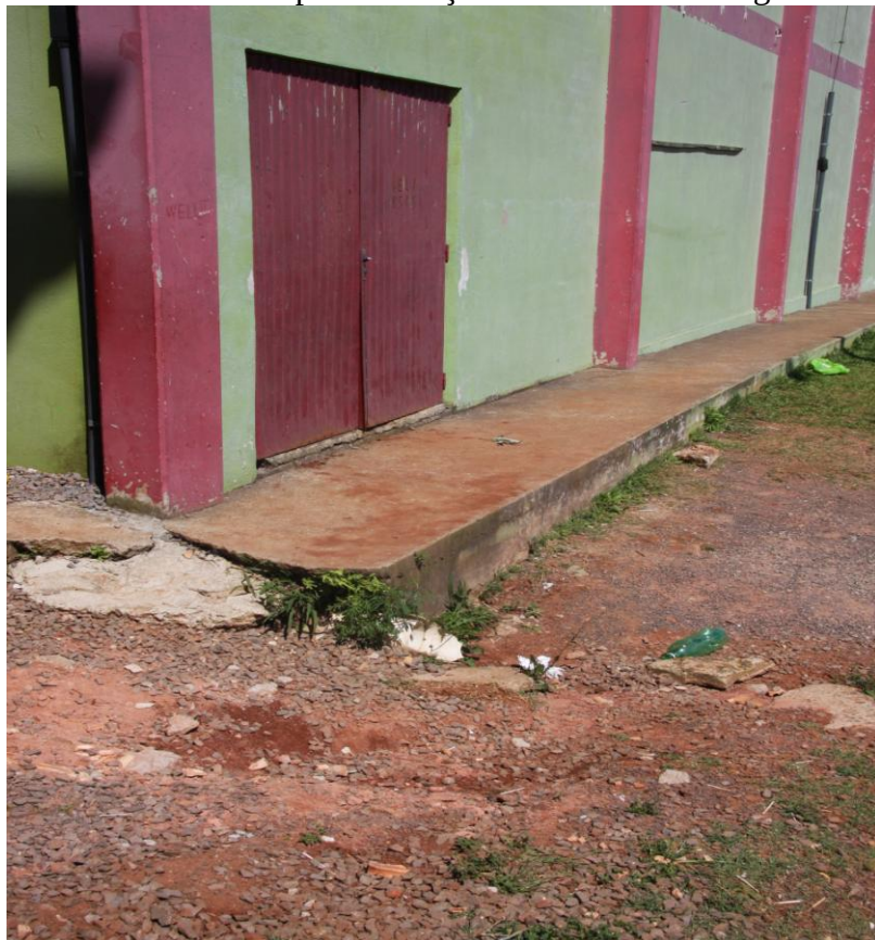
Falta construir a cobertura e reparar o calçamento no acesso ao ginásio de esportes
