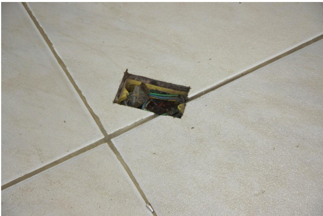
Fiação elétrica exposta no piso da sala de informática
