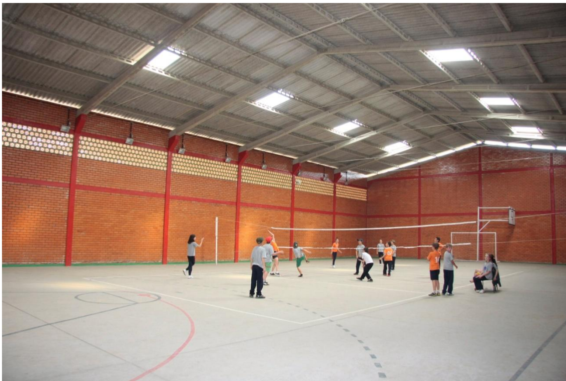
Quadra coberta nova, porém com pouca ventilação e com problemas na rede elétrica, impossibilitando que a luz seja ligada
