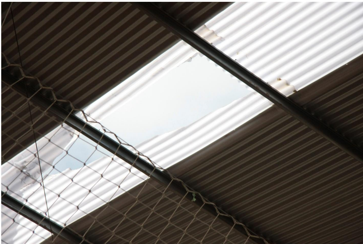
Ginásio de esportes pouco ventilado. Telhado arrancado por vendaval.
