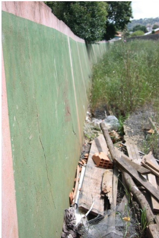
Muro desabando e podendo cair em cima de uma casa vizinha
