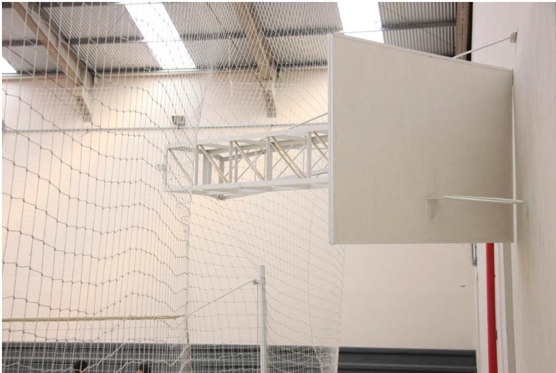
Rede de proteção do ginásio colocada de forma errada impedindo o uso da tabela de basquete.
