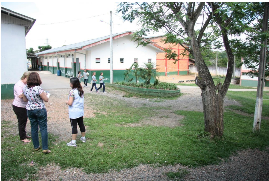
Falta calçamento e cobertura entre as alas da escola
