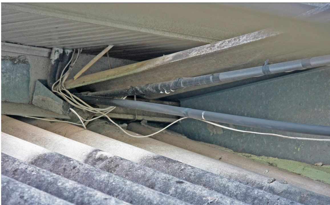
Cobertura do corredor da sala de livros.
