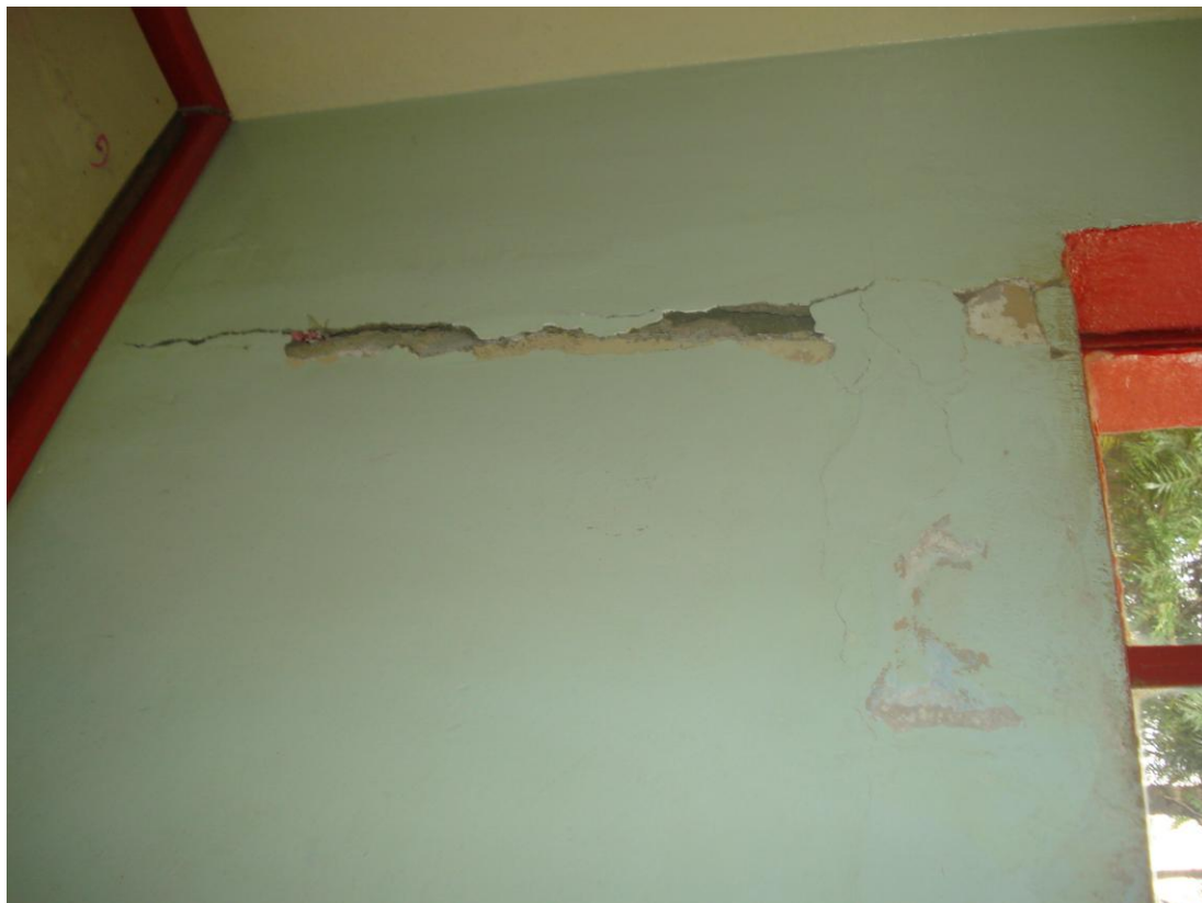
Rachaduras em toda estrutura
