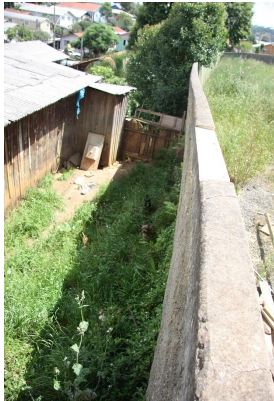
Muro desabando e podendo cair em cima de uma casa vizinha
