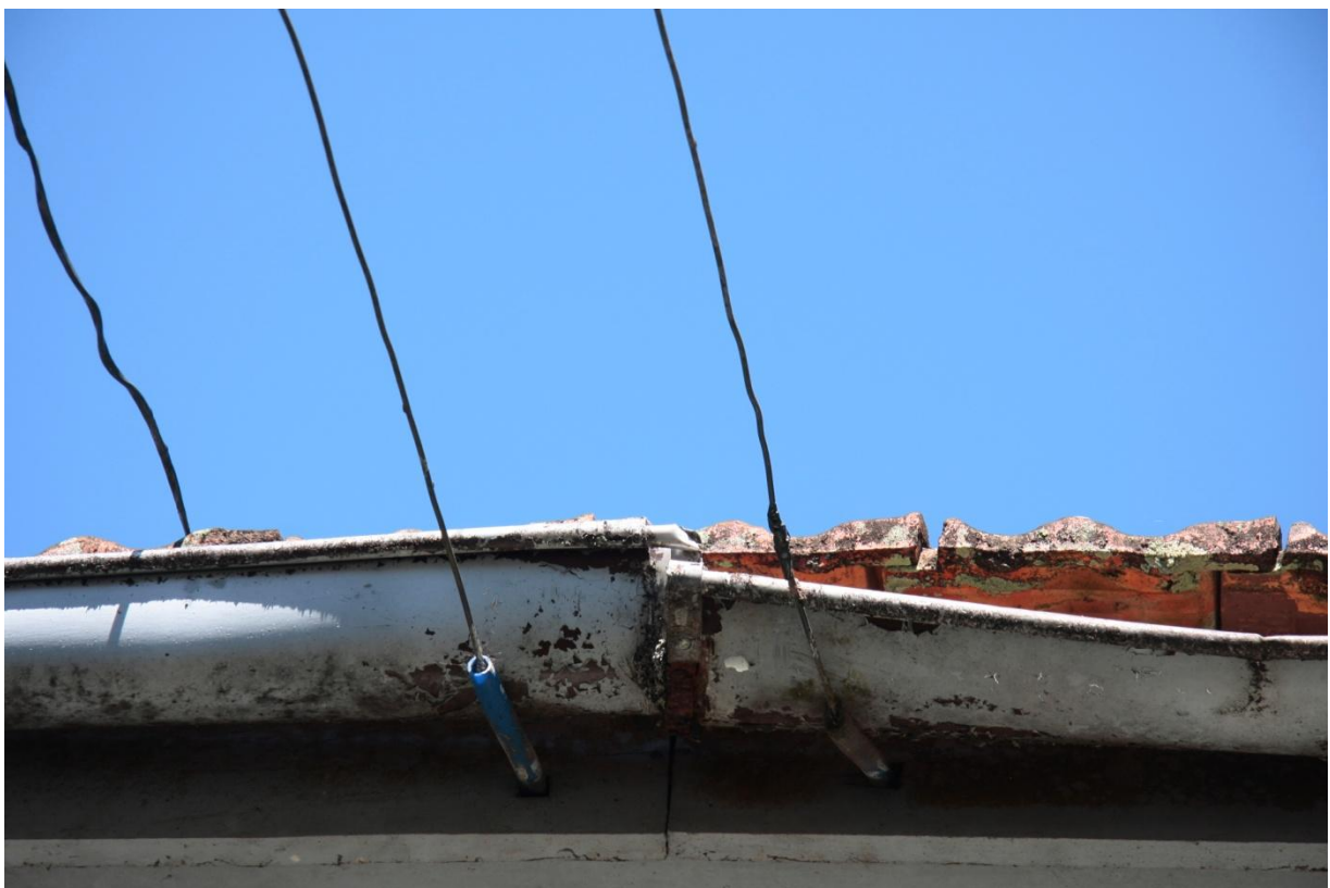
Calhas de chuva em péssimas condições
