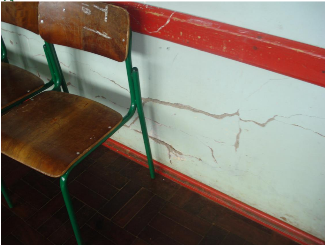
Rachaduras em toda estrutura
