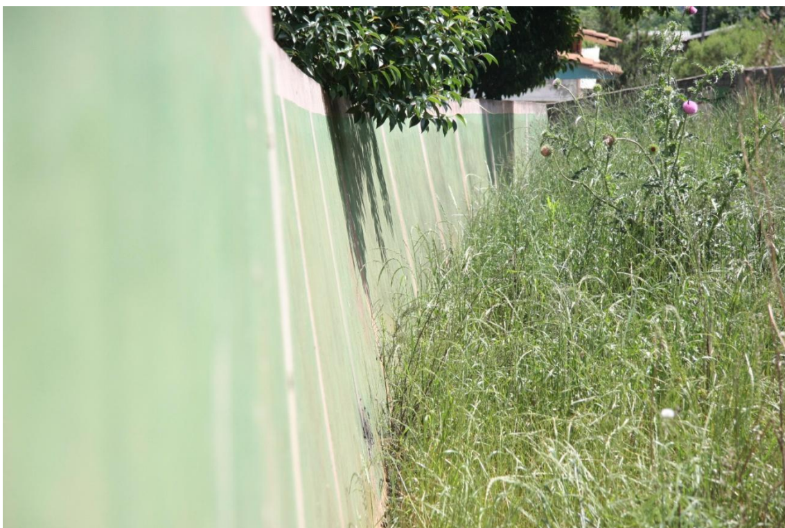
Muro desabando e podendo cair em cima de uma casa vizinha
