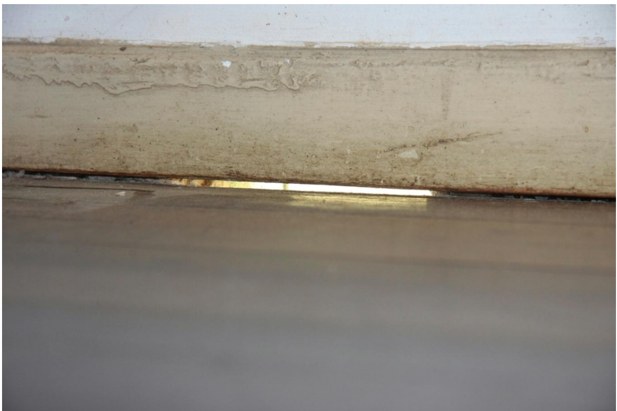
Terreno cedendo causando rachaduras e fendas na estrutura
