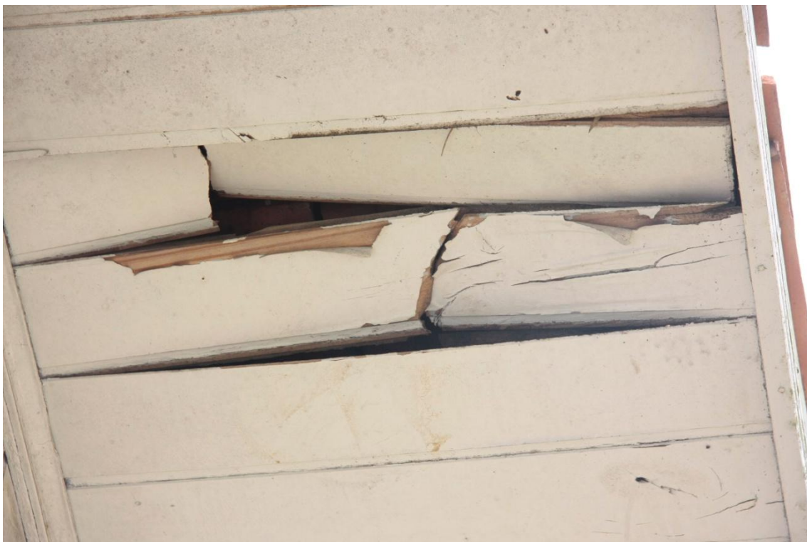
Forros caindo e com infiltrações
