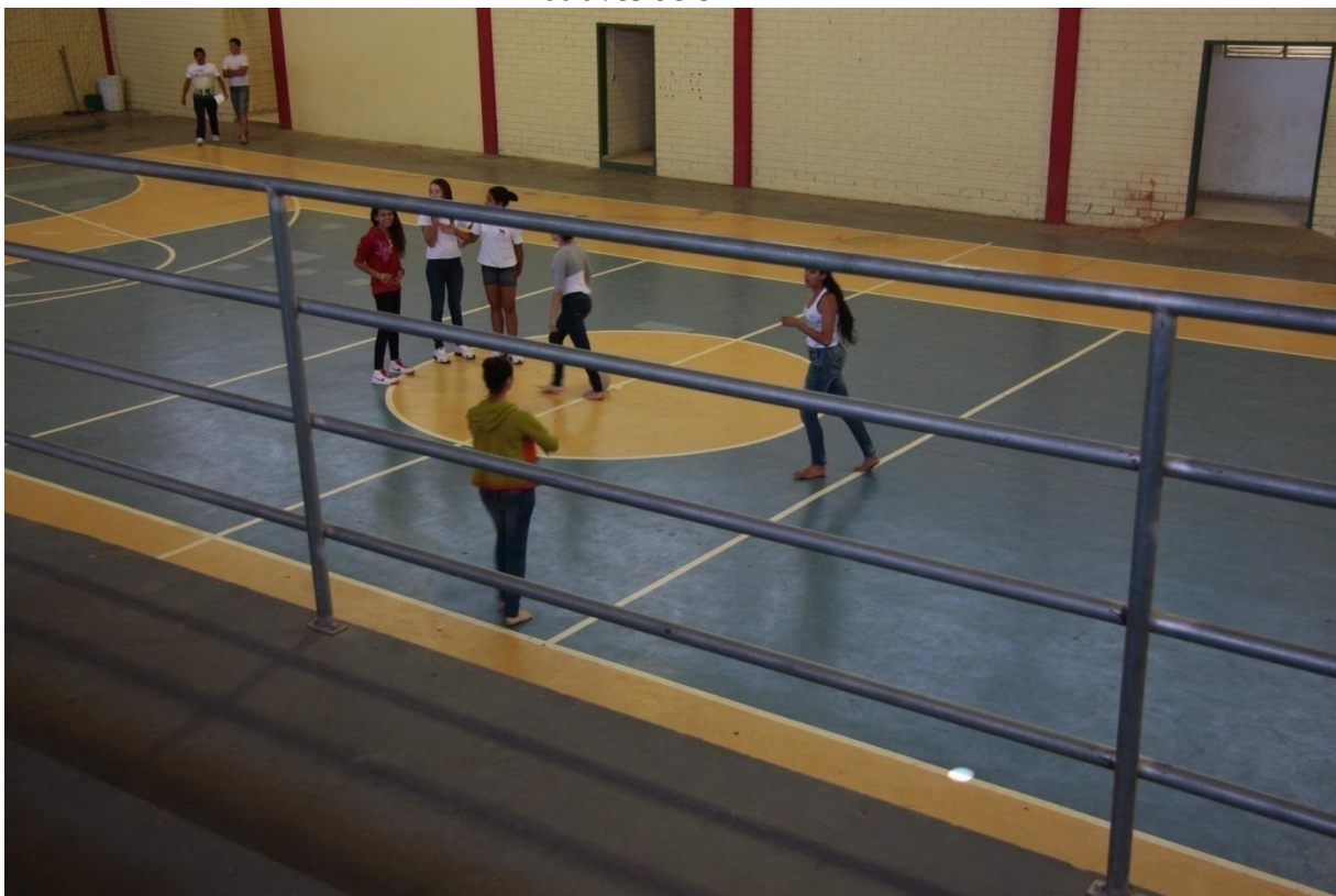
Alambrado inadequado, muito espaçoso, permitindo que um aluno pequeno passe através dele
