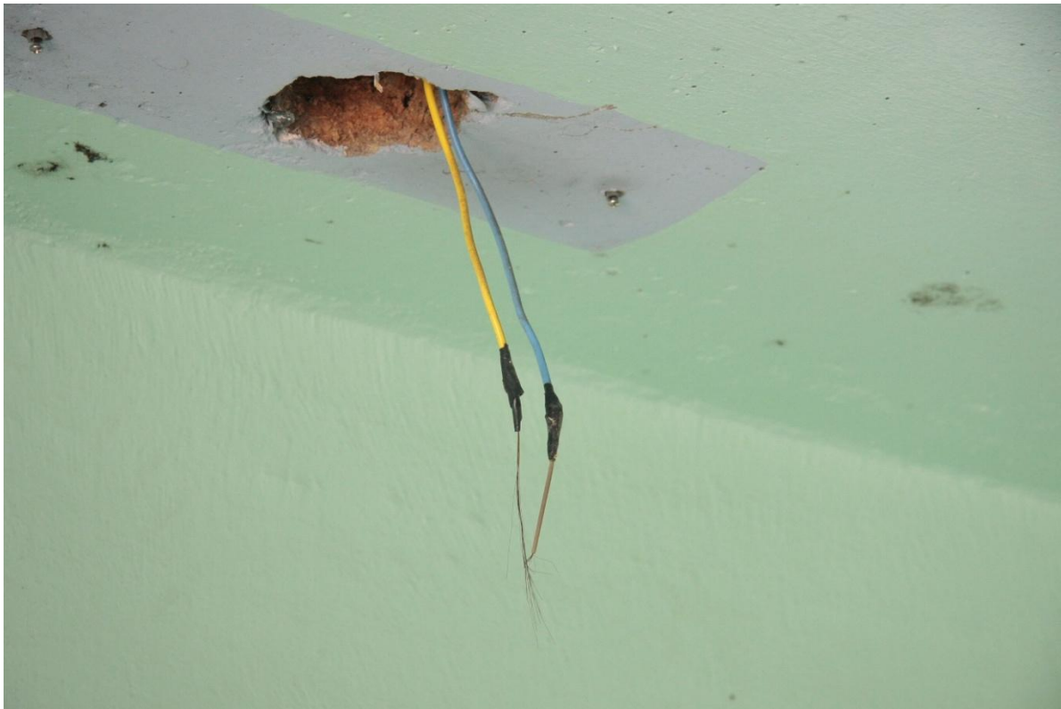
Fiação elétrica exposta no corredor da escola
