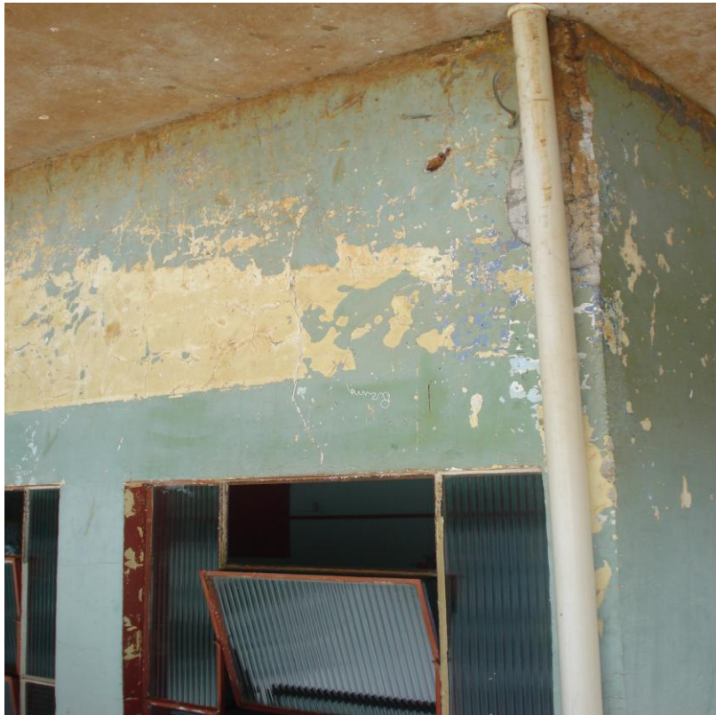
Rachaduras, infiltrações e falta de pintura em toda a estrutura escolar
