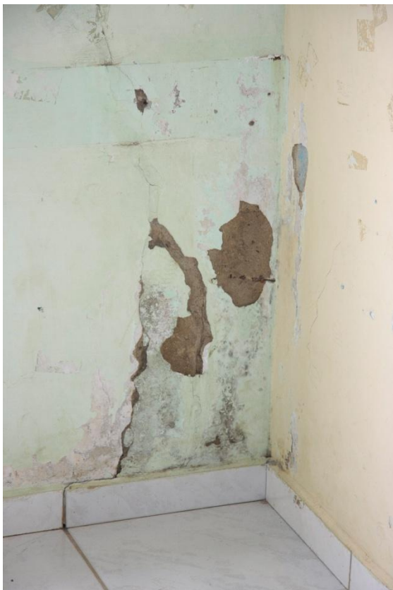
Infiltrações nas paredes
