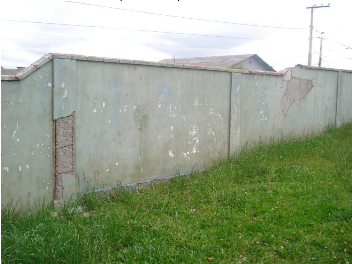
Rachaduras, infiltrações e falta de pintura em toda a estrutura escolar
