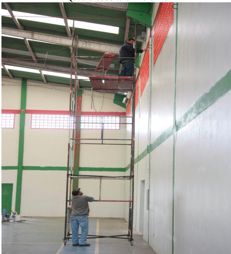
Reforma no telhado e pintura
