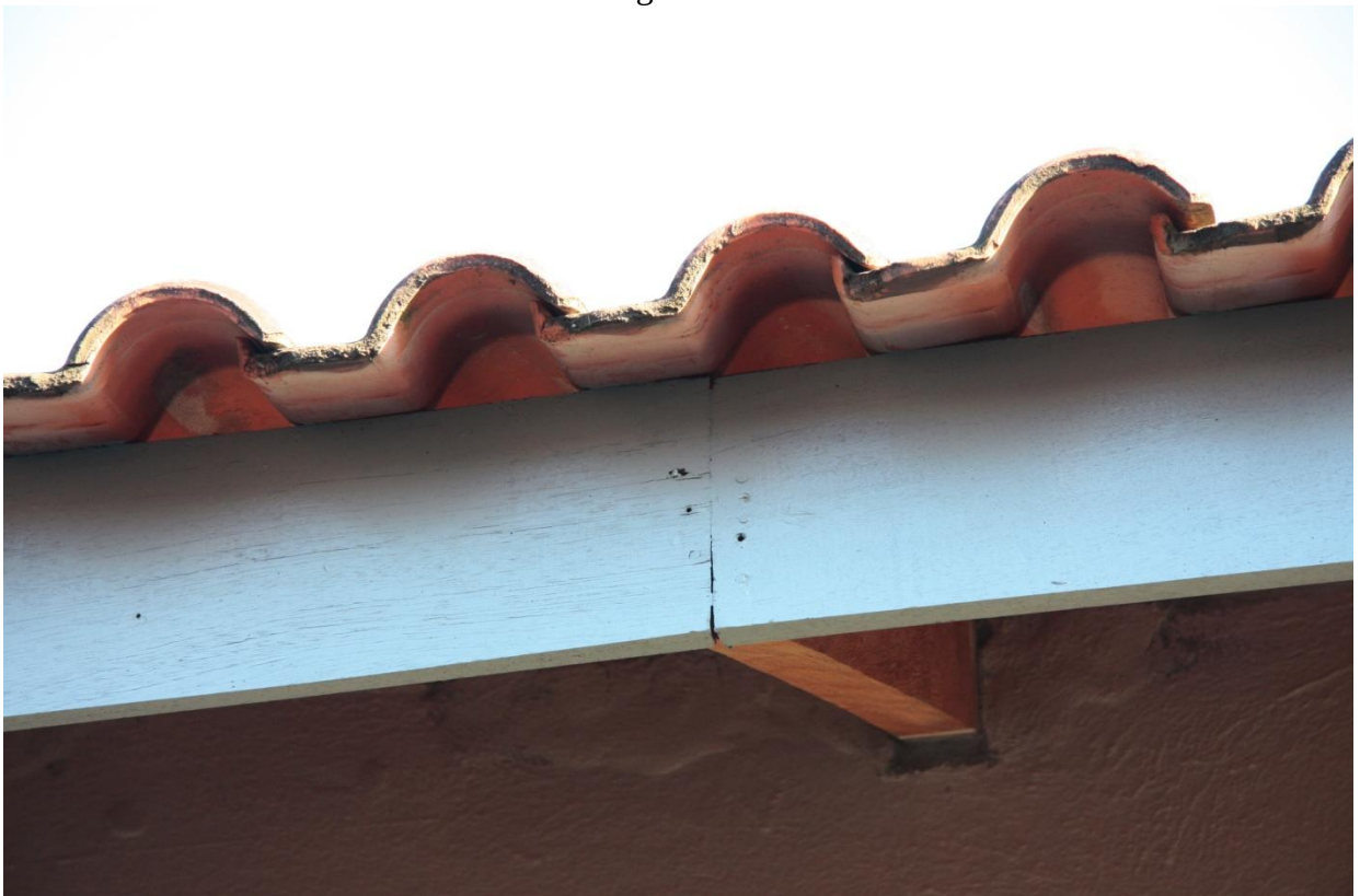
Falta calha de chuva em parte da escola e onde há calhas, não há saída subterrânea que evite os alagamentos
