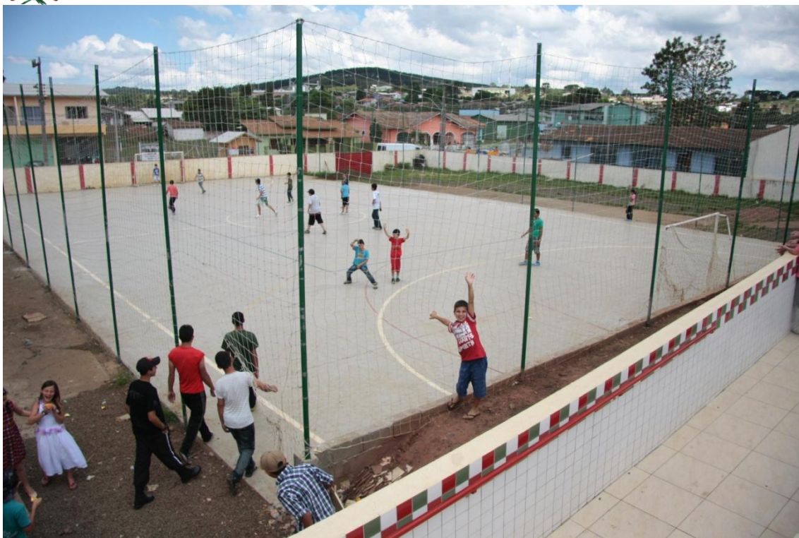
Quadra descoberta necessitando de manutenção
