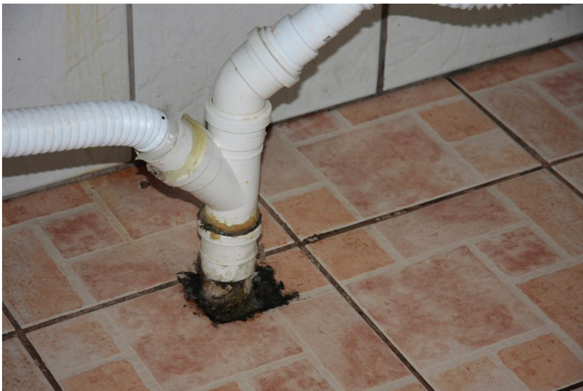
Cozinha apresenta infiltrações nas paredes, vazamento na pia e piso soltando;
