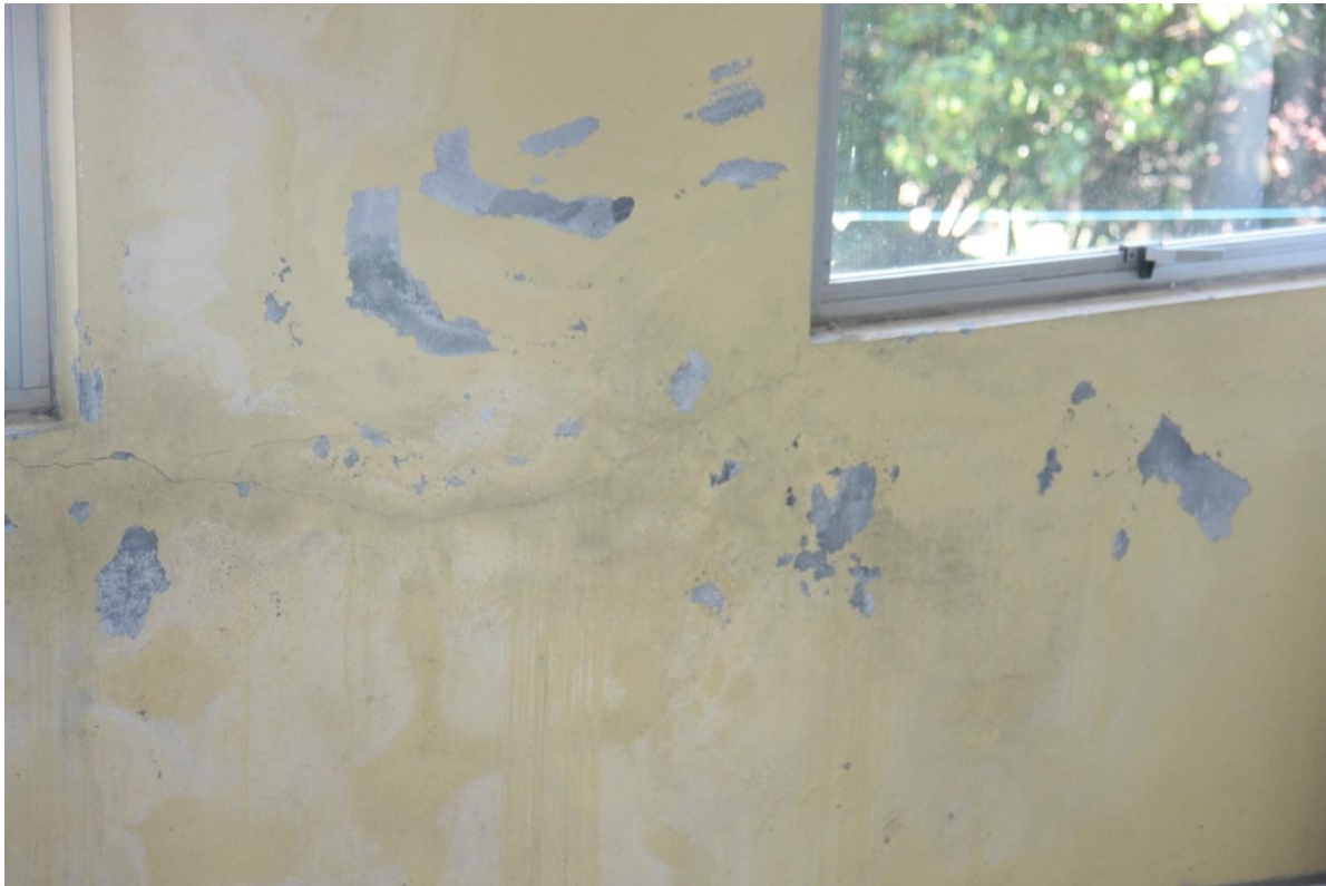
Auditório, ocupado no período noturno pela UFSC, apresenta cadeiras destruídas e infiltrações nas paredes
