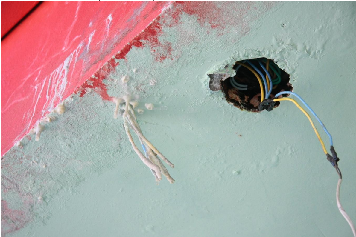
Fiação elétrica exposta no corredor da escola
