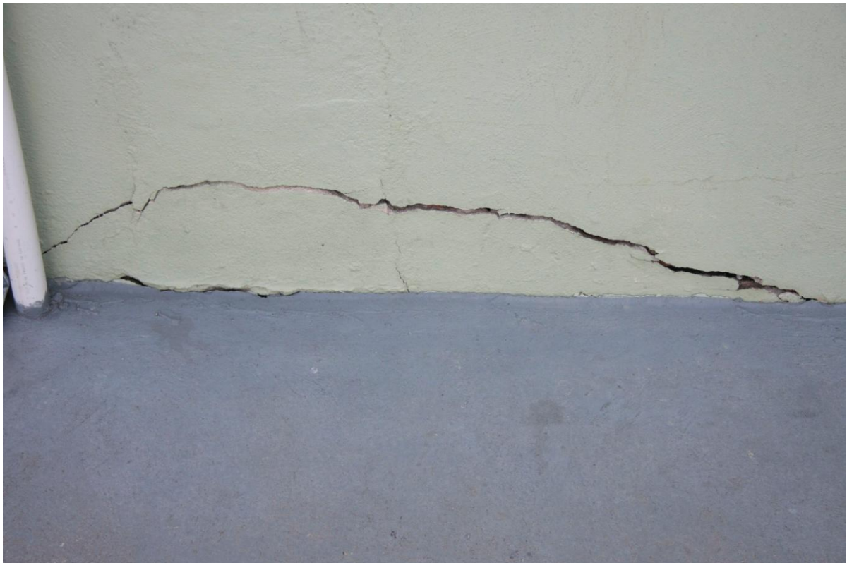
Terreno cedendo causando rachaduras e fendas na estrutura
