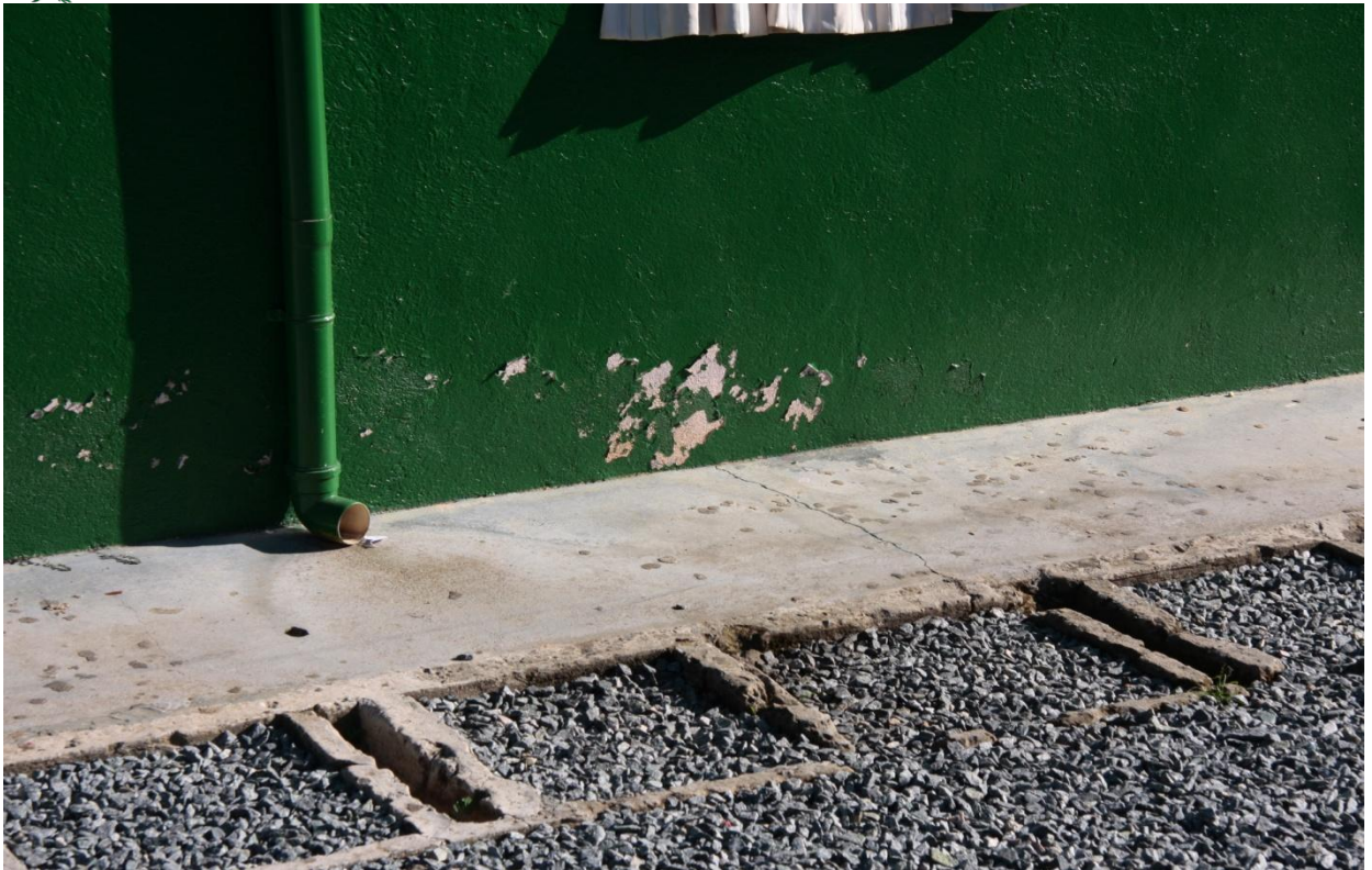
Falta calha de chuva em parte da escola e onde há calhas, não há saída subterrânea que evite os alagamentos
