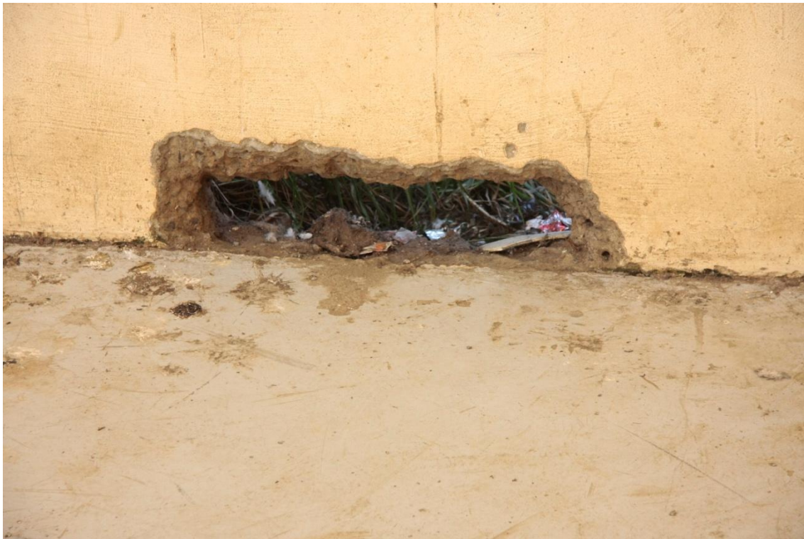
Buraco feito no ginásio para escoamento da água
