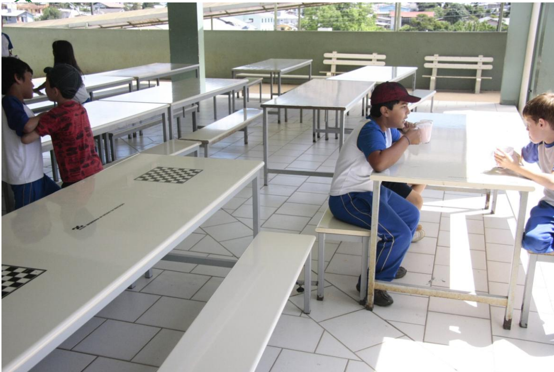
Refeitório necessitando ser fechado devido ao frio extremo inverno e ao calor excessivo do verão
