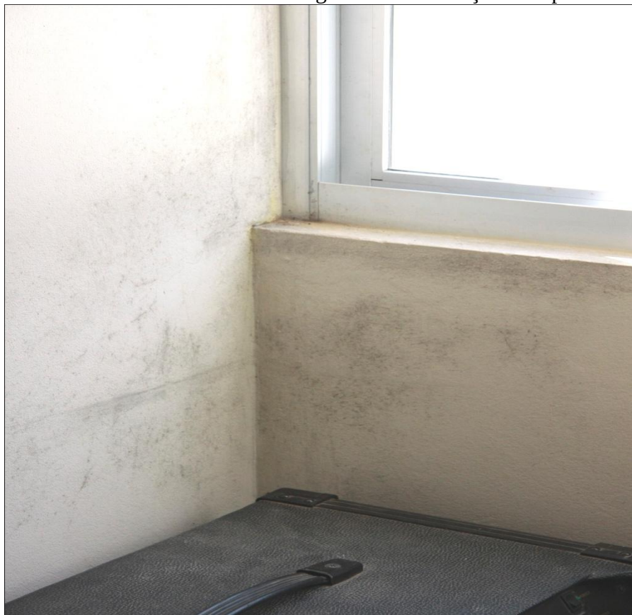
Sala de informática com muitas goteiras e infiltrações nas paredes
