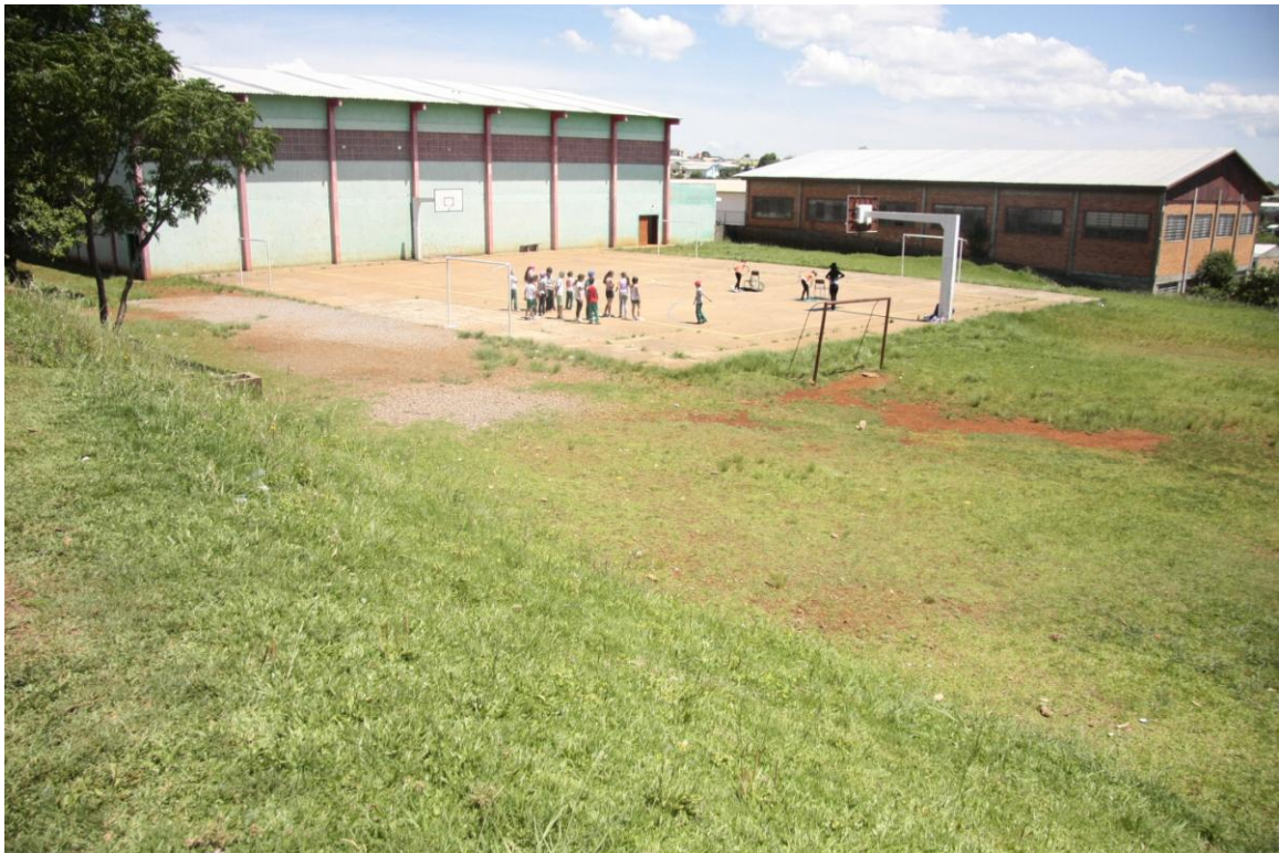
Falta manutenção da quadra descoberta e cobertura no acesso ao ginásio de esportes
