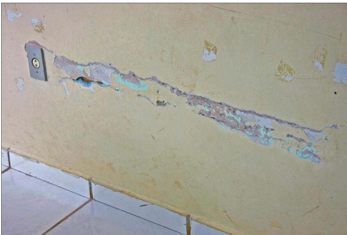
Infiltrações nas paredes
