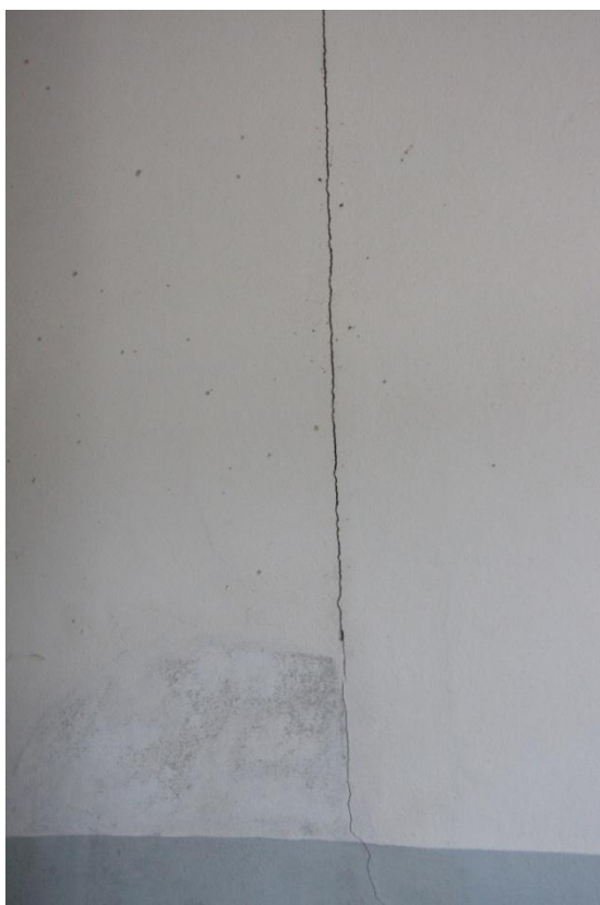
Algumas rachaduras na estrutura
