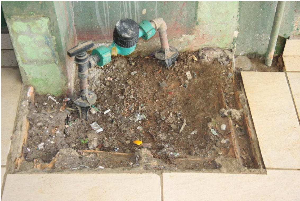
Relógio de água instalado dentro do colégio em local inapropriado
