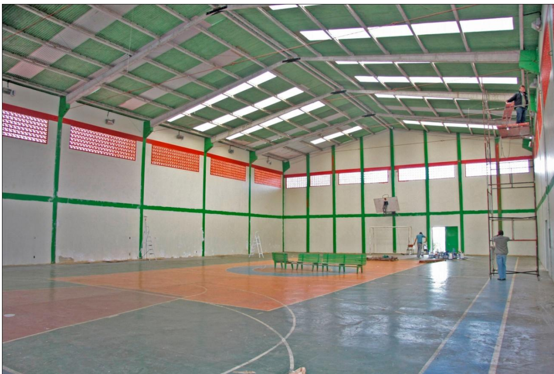
Quadra coberta em reforma
