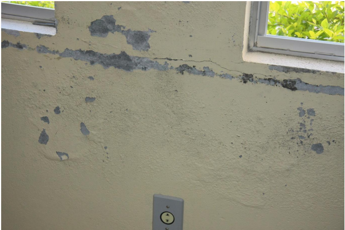
Infiltrações nas paredes de quase toda a estrutura
