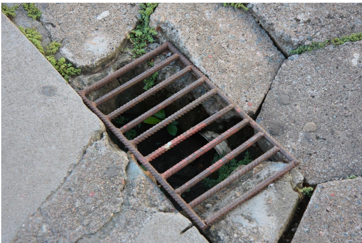
Galeria fluvial da rua não tem capacidade de escoamento, permitindo que em dias de chuva forte ocorram alagamentos na escola
