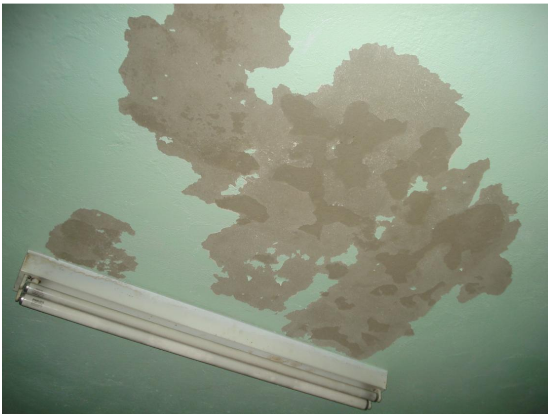
Infiltrações e goteiras no teto.
