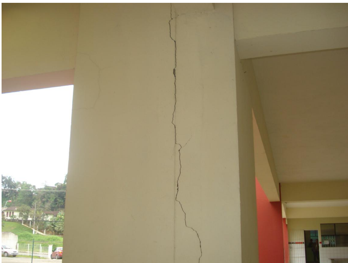
Rachaduras em vigas de sustentação do prédio escolar.
