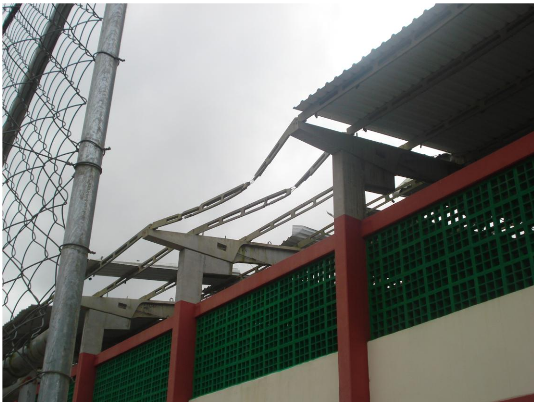
Ginásio de Esportes destelhado por um vendaval no ano de 2012.
