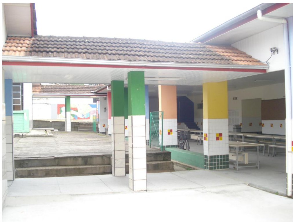
Falta de rampas de acesso.
