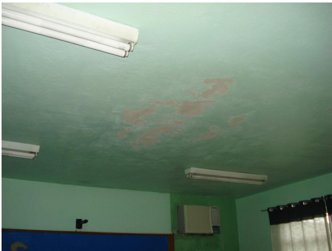
Infiltrações e goteiras no teto.
