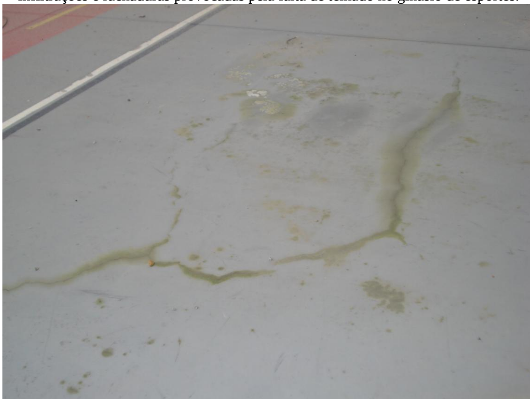
Infiltrações e rachaduras provocadas pela falta de telhado no ginásio de esportes.
