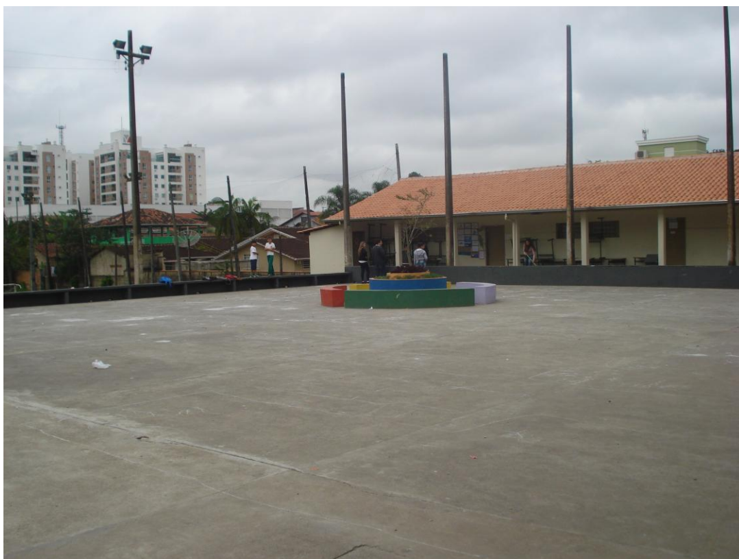
Área para Educação Física necessitando de manutenção.
