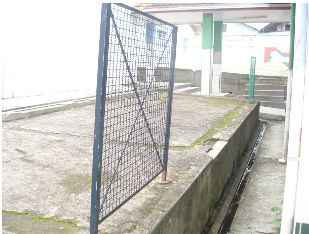
Valas abertas ligando uma ala à outra e sem grade de proteção.
