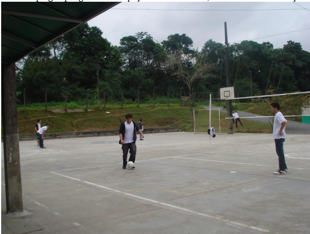
Quadra descoberta necessitando de manutenção.
