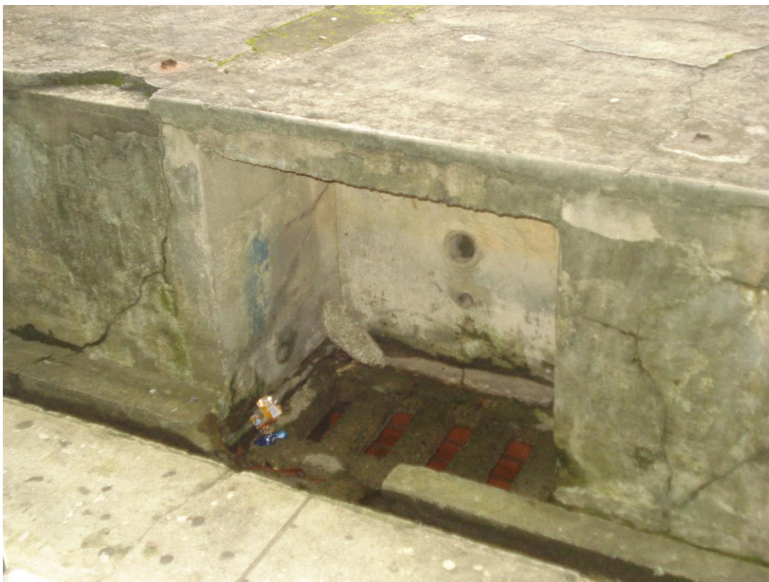
Sistema de esgoto aberto no pátio da escola.
