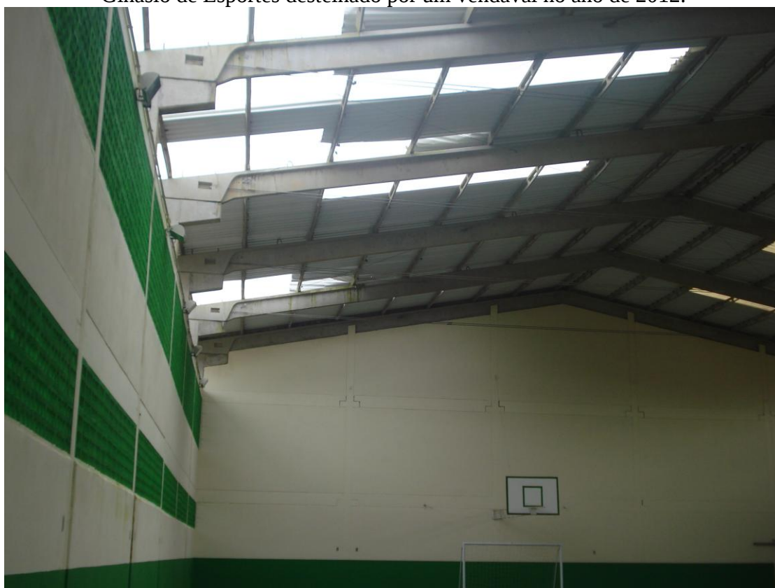
Ginásio de Esportes destelhado por um vendaval no ano de 2012.
