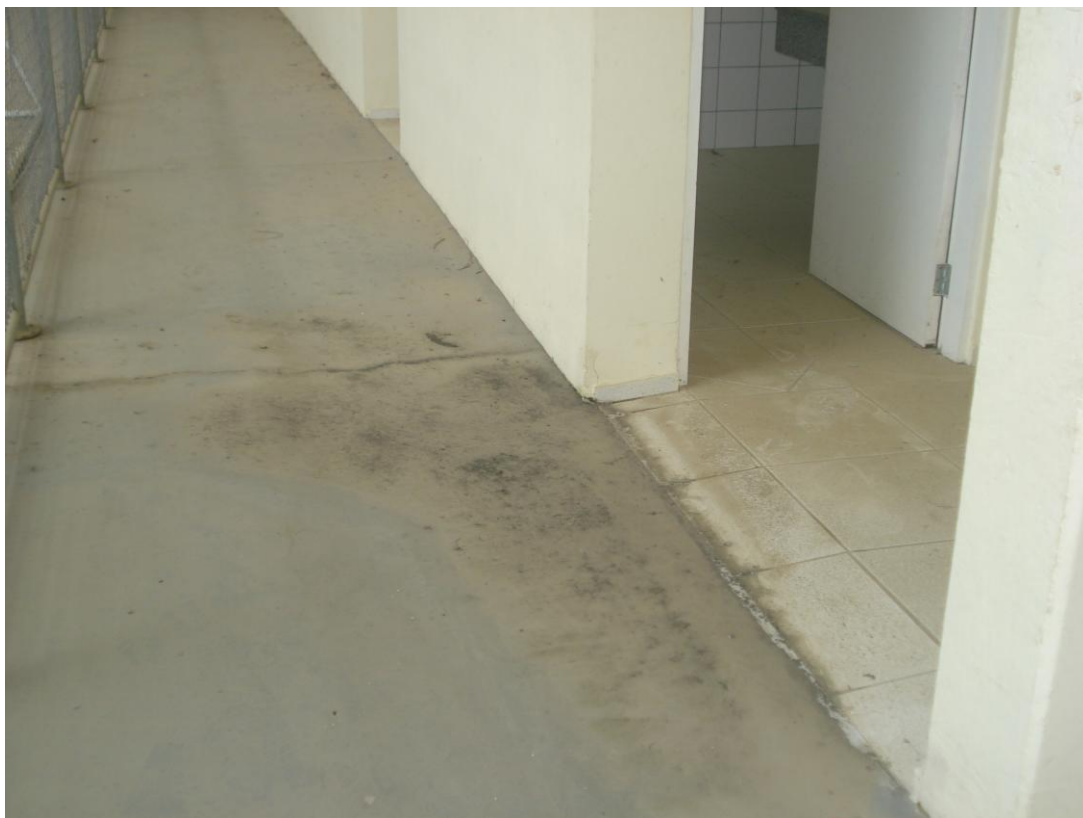
Infiltrações e rachaduras provocadas pela falta de telhado no ginásio de esportes.
