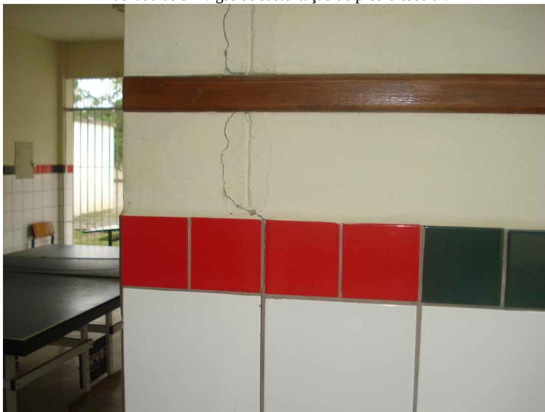
Rachaduras em vigas de sustentação do prédio escolar.
