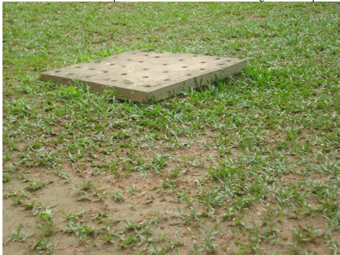
“Boca de lobo” mais alta que o terreno causando constantes alagamentos no pátio.
