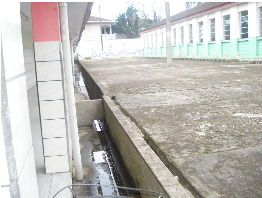
Valas abertas ligando uma ala à outra e sem grade de proteção.
