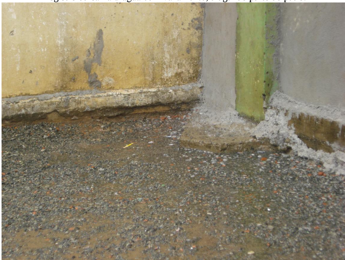
Registro da caixa d'água com vazamento, alagando parte do pátio.
