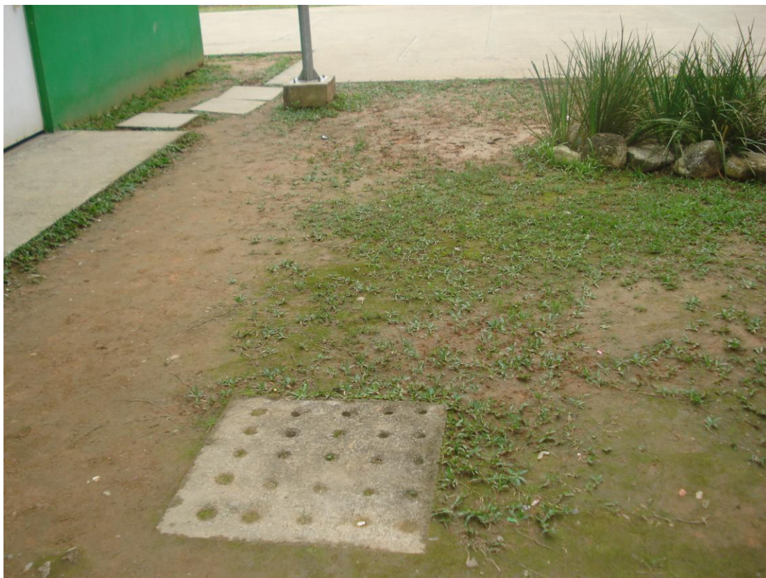
“Boca de lobo” mais alta que o terreno causando constantes alagamentos no pátio.
