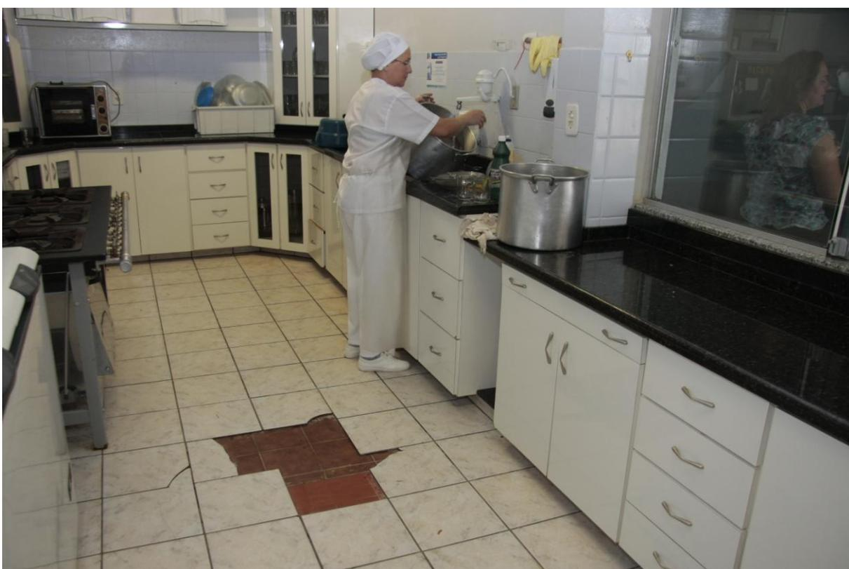
Cozinha com rachaduras no teto e pisos soltando
