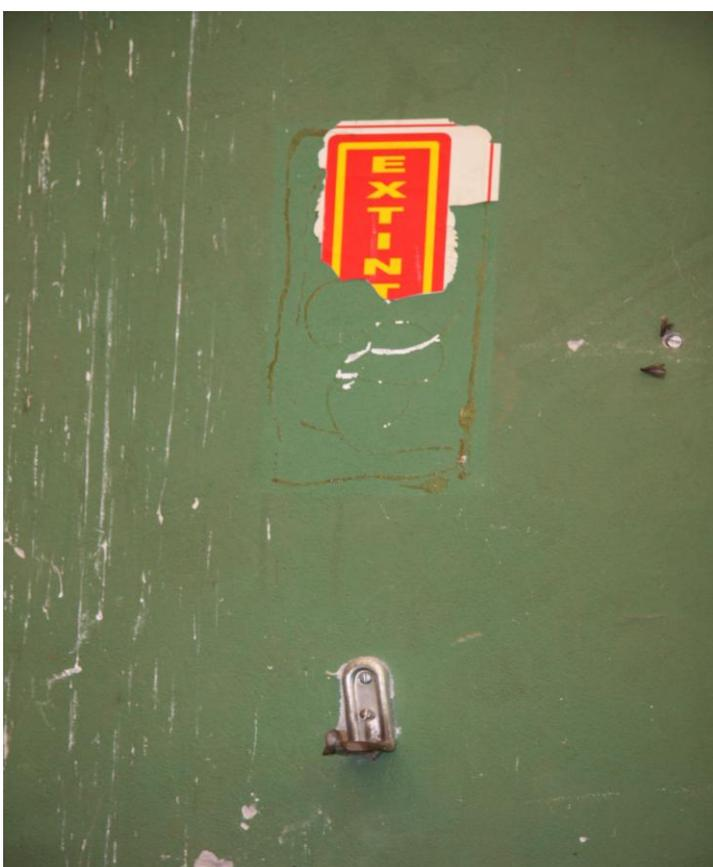
Falta de equipamento de combate a incêndio no ginásio de esportes
