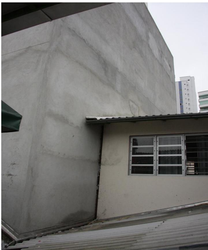
Edifício Residencial sendo construído rente à estrutura da escola causando sérios problemas de infiltrações, quebras de telha devido a queda de material de construção
