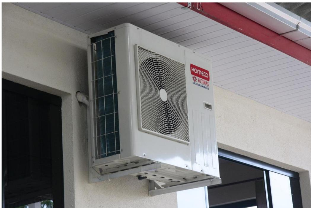
Das 14 salas de aula apenas 10 possuem climatizadores, porém os mesmos foram apenas colocados na parede devido a falta de instalação elétrica
