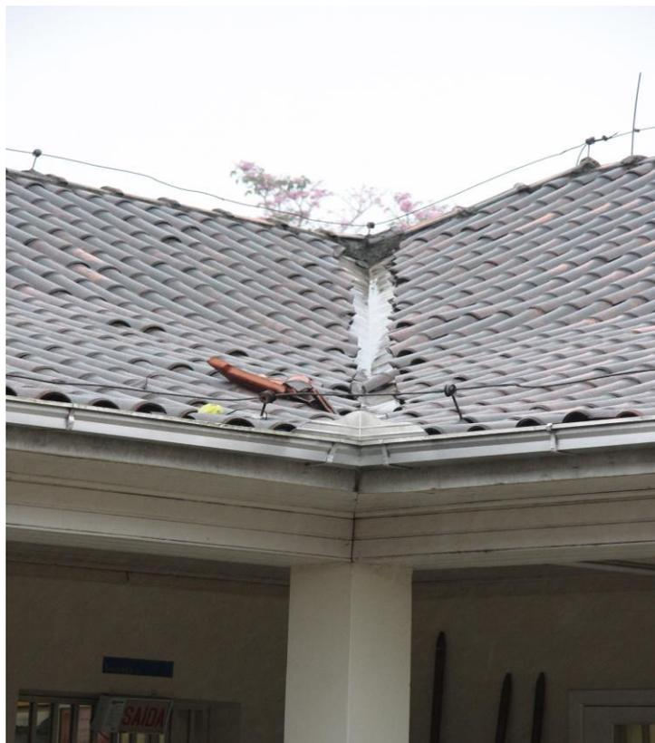
Telhas quebradas causando goteiras
