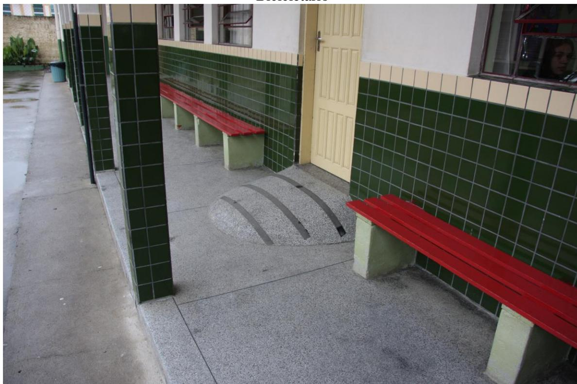
Rampa de acesso inadequada, dificultando a passagem de alunos com necessidade de locomoção
