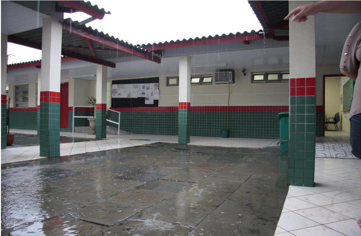
Faltam calhas de chuva em toda a estrutura escolar, escoamento e drenagem para a água da chuva que fica represada no pátio causando alagamentos na escola
