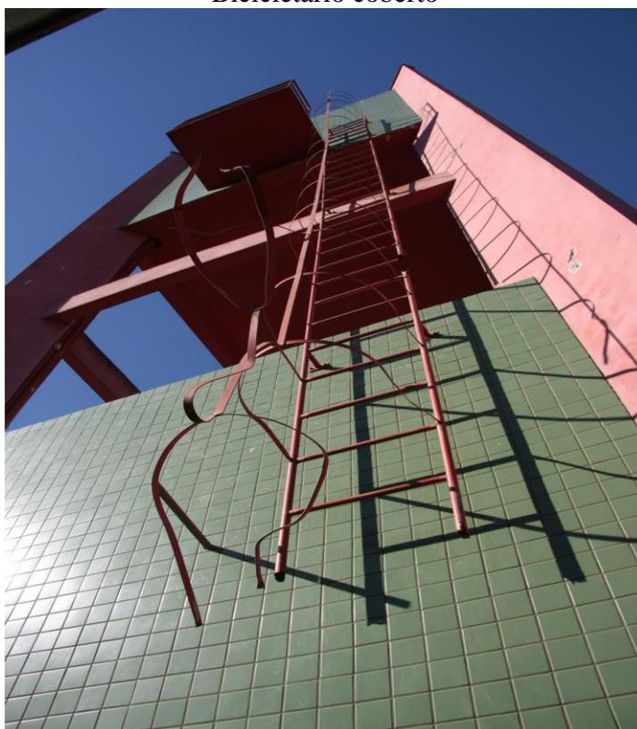
Caixa d'água explodiu e foi lançada a alguns metros devido à falta de ladrão
