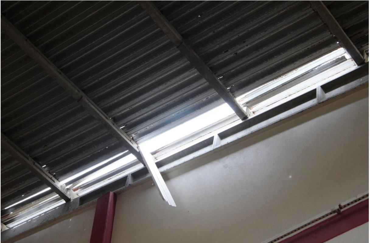
Telhado caindo e provocando poças de água no ginásio impedindo a prática de educação física
