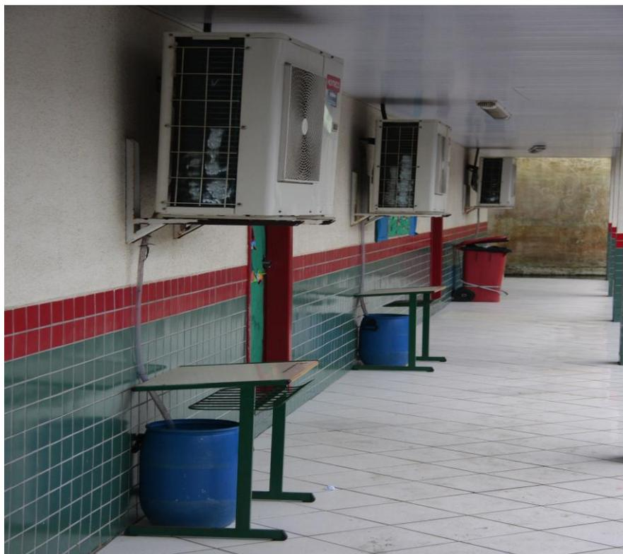
Apesar da rede elétrica ter sido refeita para receber os climatizadores a mesma continua sendo insuficiente e não há escoamento para a água dos climatizadores
