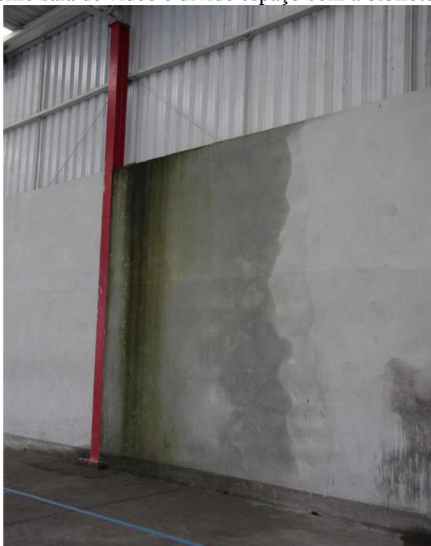
Infiltrações na parede da quadra coberta causada pela construção de um edifício residencial ao lado da estrutura
