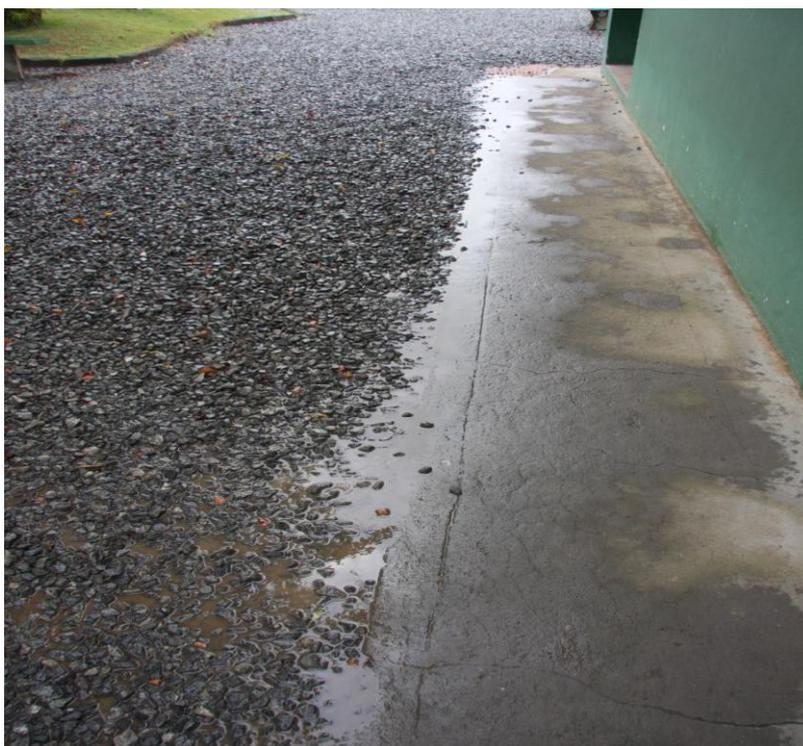
Calçadas existentes na altura da brita e devido a falta de drenagem da água a escola sofre com constantes alagamentos em dias de chuva forte
